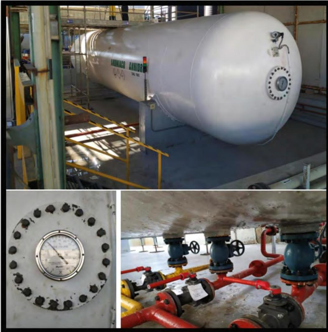
**Figura 14D.** Recipiente de Amoniaco, indicador de nivel y válvulas de descarga. (Tomada de guía operativa. Actuaciones con amoniaco para bomberos <https://www.bombersdv.es/wp-content/uploads/2019/02/V12-GUIA-AMONIACO-GT11.pdf>)
