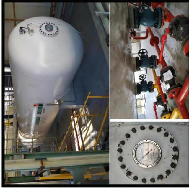
Figura 15C. Recipiente de Amoniaco, indicador de nivel y válvulas de descarga. (Tomada de guía operativa. Actuaciones con amoniaco para bomberos <https://www.bombersdv.es/wp-content/uploads/2019/02/V12-GUIA-AMONIACO-GT11.pdf>)
