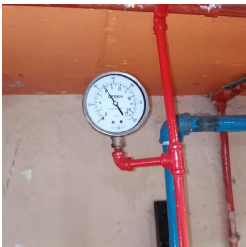
Fuente: Elaboración propia. (2023) Fig. 3.2 Manómetro
