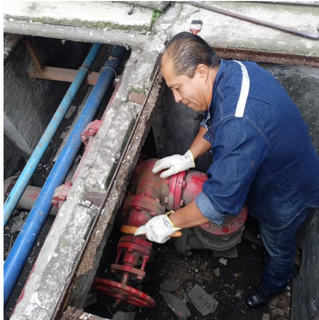
Fig. 3.18 Tubería en trinchera
