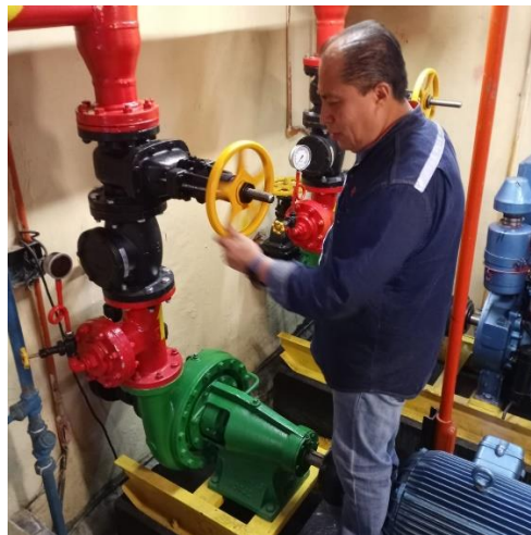
Fig. 3.3 Apertura y cierre de los volantes de las válvulas de compuerta
