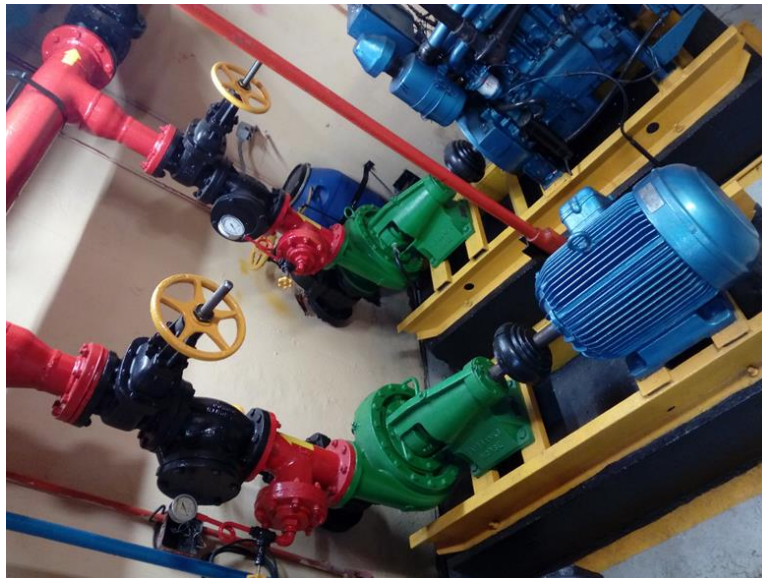
Fuente: Elaboración propia. (2023) Fig. 3.5 Bomba con motor eléctrico
