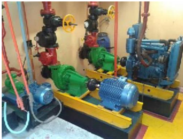
Fig. 3.1 Sala de Bombas compuesta por las motobombas Jockey, Eléctrica o Principal y la de Combustión Interna.
