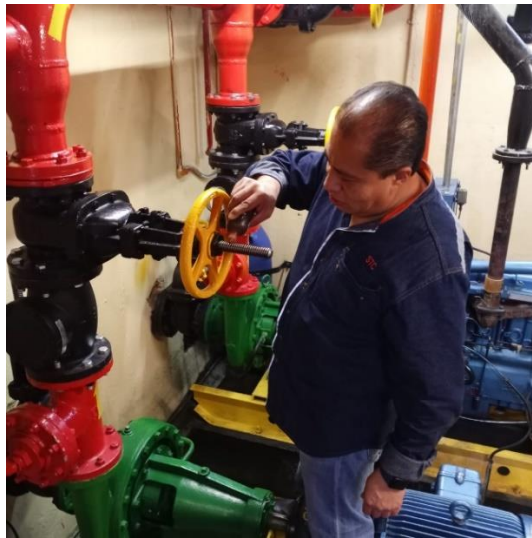
Fig. 3.4 Lubricación de válvulas de seccionamiento
