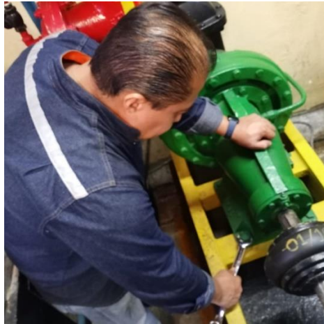
Fuente: Elaboración propia. (2023) Fig. 3.6 Apriete de tornillería de anclaje
