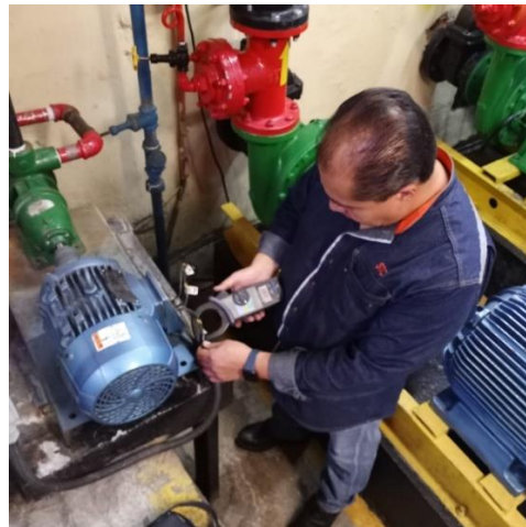
Fig. 3.13 Toma de lectura de corriente
