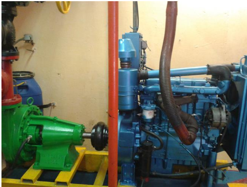
Fig. 3.8 Bomba con Motor de Combustión Interna
