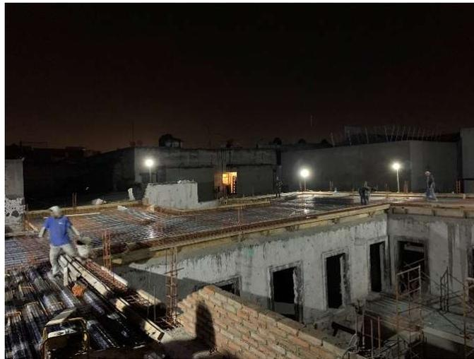
**Imagen 75.** Preparación para colado nocturno en azotea
