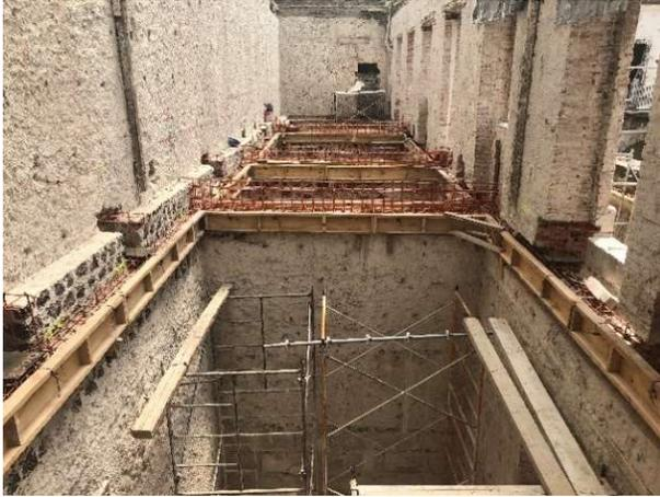
**Imagen 73.** Cadena perimetral de concreto en muro
