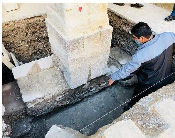
**Imagen 10.** *Cala 5. Cimentación de columna esquina*    **Imagen 11.** *Cala 5. Cimentación de columna*
