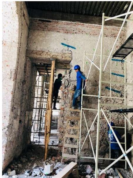
**Imagen 71.** Muro con hueco en su interior
