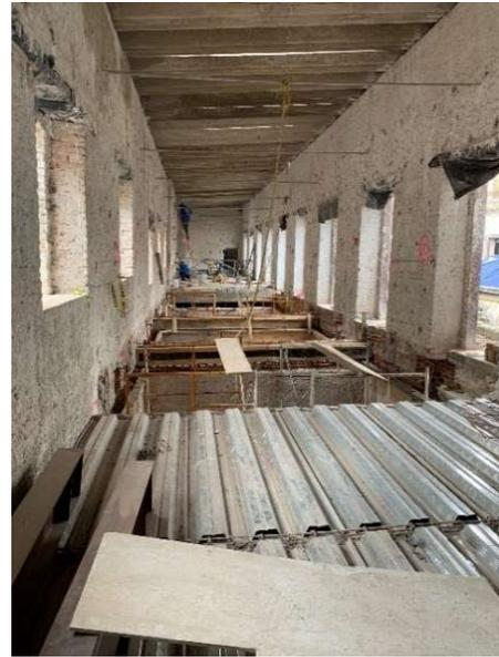
**Imagen 74.** Instalación de losacero
