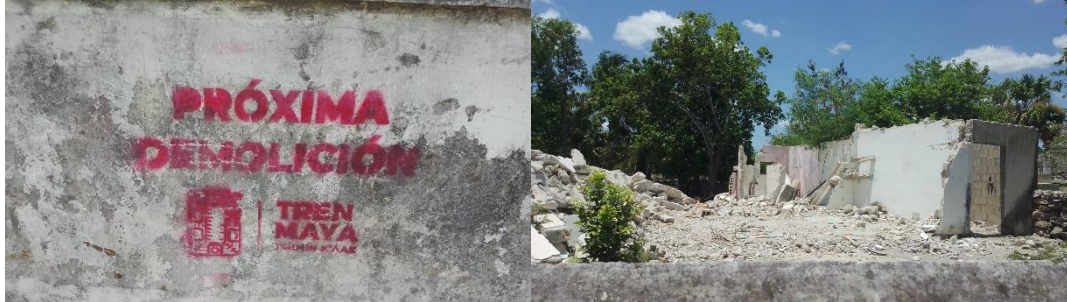
Imagen 7. Casa en demolición por el paso de vías del TM.
