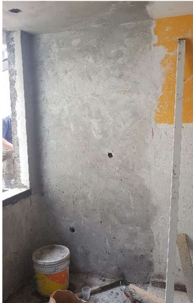
IMAGEN 005. CONSTRUCCIÓN DE MURO EN HABITACIÓN DE HIJA MENOR CASA AJUSCO. HOPELCHÉN 254 AUTOR: MANUEL CAMARILLO L JULIO -2020
