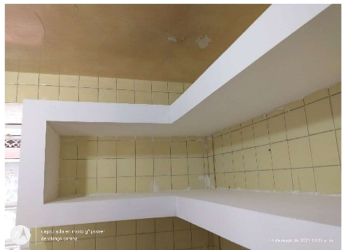
IMAGEN 056. REPISA SUPERIOR PERIMETRAL ACABADO FINAL. COCINA BELLAS ARTES. AUTOR: MANUEL CAMARILLO L. / MAYO 2021
