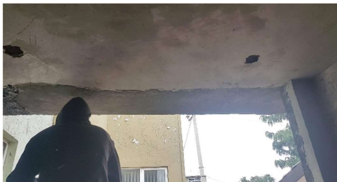
IMAGEN 003. LOSA DE SEGUNDO NIVEL CON PREPARACIÓN PARA LUMINARIAS CASA AJUSCO. HOPELCHÉN 254 AUTOR: MANUEL CAMARILLO L JULIO -2020
