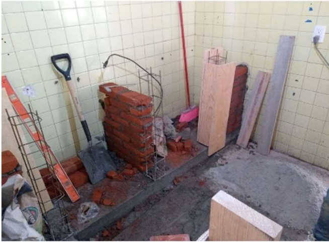
IMAGEN 052. CONSTRUCCIÓN DE DIVISIÓN A BASE DE MAMPOSTERÍA. COCINA BELLAS ARTES. AUTOR: MANUEL CAMARILLO L. / MAYO 2021
