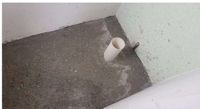
IMAGEN 004. LOSA DE SEGUNDO NIVEL. SALIDA HIDROSANITARIA CASA AJUSCO. HOPELCHÉN 254 AUTOR: MANUEL CAMARILLO L JULIO -2020
