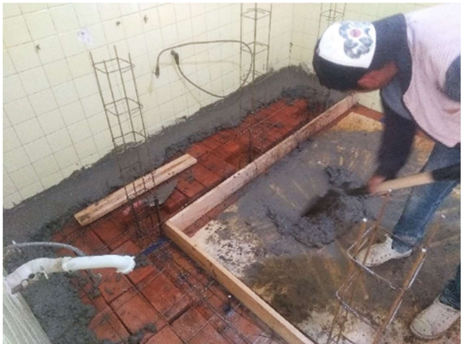
IMAGEN 051. COLADO DE LOSA INFERIOR. COCINA BELLAS ARTES. AUTOR: MANUEL CAMARILLO L. / MAYO 2021
