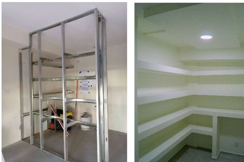
IMAGEN 038 / 039 CONSTRUCCIÓN DE BODEGA A BASE DE TABLA-ROCA FOTO IZQUIERDA ESTRUCTURA / FOTO DERECHA ACABADO. FARMACIA ADEXIA. AUTOR: MANUEL CAMARILLO L. / ENERO -2021
