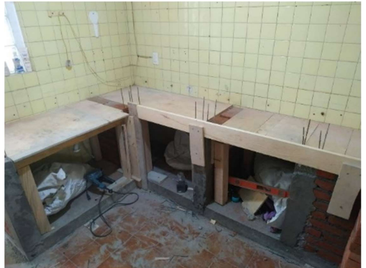
IMAGEN 053. COLADO DE LOSA SUPERIOR. COCINA BELLAS ARTES. AUTOR: MANUEL CAMARILLO L. / MAYO 2021
