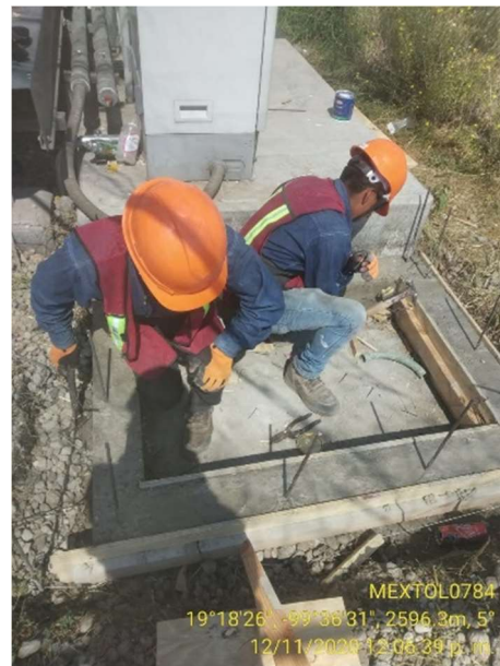
IMAGEN 025 EVIDENCIA DE CONSTRUCCIÓN DE BASE DE CONCRETO PARA GABINETE. INSTALCIÓN DE ANTENAS HUAWEI. AUTOR: LÍDER DE CUADRILLA -2020
