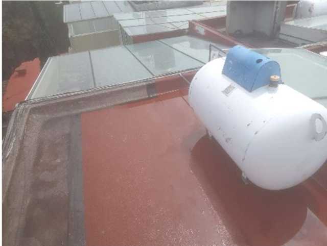
IMAGEN 011. CUBIERTA EXISTENTE CON NUEVA CARPETA ASFÁLTICA CASA AJUSCO. HOPELCHÉN 254 AUTOR: MANUEL CAMARILLO L JULIO -2020
