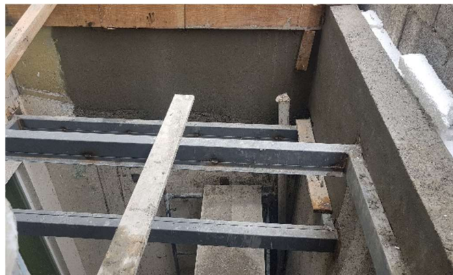
IMAGEN 012. CONSTRUCCIÓN DE PÉRGOLA A BASE DE PTR DE ACERO CASA AJUSCO. HOPELCHÉN 254 AUTOR: MANUEL CAMARILLO L. / JULIO -2020
