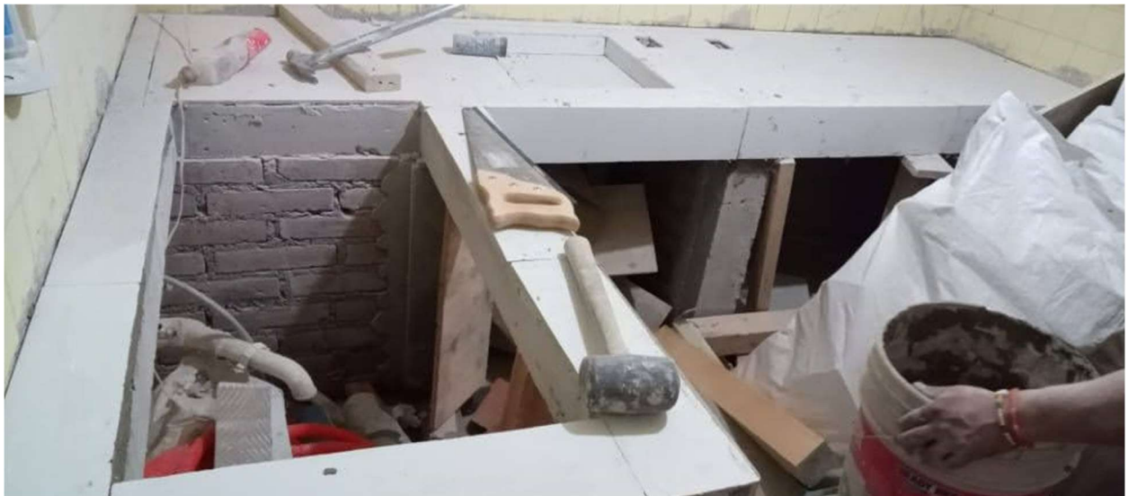
IMAGEN 057. COLOCACIÓN DE PORCELANATO EN BARRA DE CONCRETO. COCINA BELLAS ARTES. AUTOR: MANUEL CAMARILLO L. / MAYO 2021
