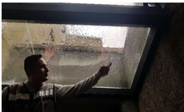
IMAGEN 013. PÉRGOLA CON CRISTAL CLARO Y PELÍCULA DE CONTROL SOLAR CASA AJUSCO. HOPELCHÉN 254 AUTOR: MANUEL CAMARILLO L.
