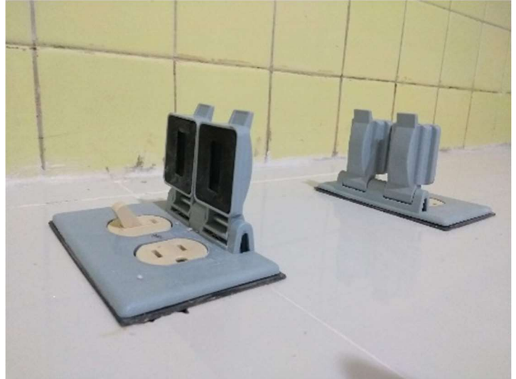
IMAGEN 054. SALIDA DE APAGADORES EN LOSA SUPERIOR. COCINA BELLAS ARTES. AUTOR: MANUEL CAMARILLO L. / MAYO 2021
