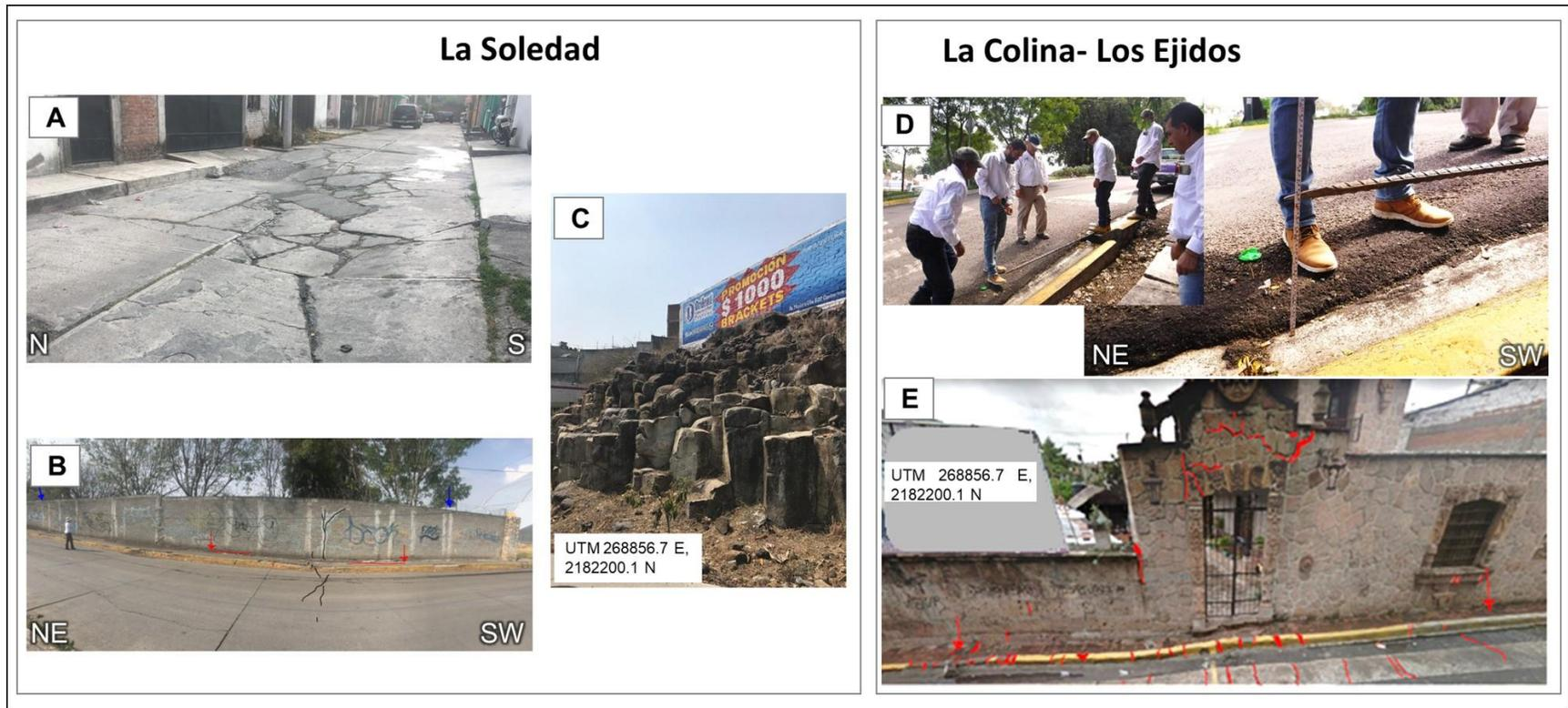
Figura 4.16. Fotografías que muestran afectaciones estructurales en la ciudad de Morelia. A) y B) muestran el fracturamiento en paredes y vías de concreto en la colonia La Soledad (marzo, 2021). C) Lavas de Tetillas aflorando en el área urbana en las cercanías a la colonia La Soledad (marzo, 2021). D) y E) fracturas abiertas y grietas en vías de concreto y paredes en la zona de La Colina (calle Cantero, octubre, 2023) y Los Ejidos (marzo, 2021).
