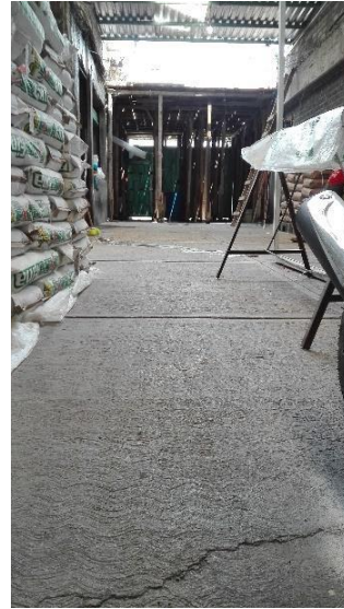
Fig. 14 Los espacios son amplios y tienen techos de lámina, lo que es fácil poder desmontar, se encuentra al fondo un zaguán y aun costado los locales que comparte el predio.
