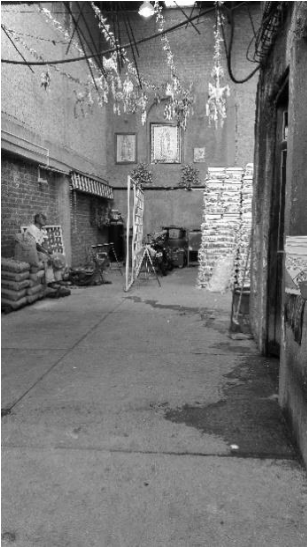
Fig. 13 Interior del predio, cuenta con doble altura, actualmente cuenta un actividad en función de molino para tortillas, cuenta con cuatro locales y espacios amplios
