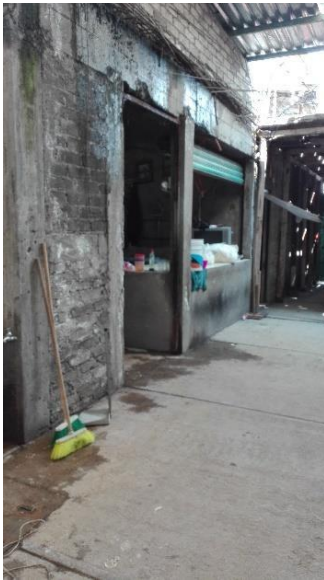
Fig. 15 Estado físico en Obra negra.
