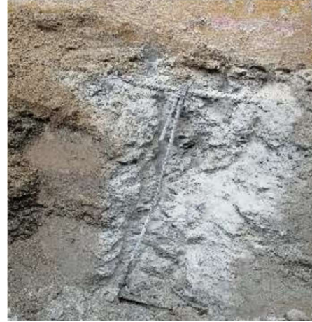
Imagen 26. Cala 3. FUEENTE: PC Constructores.
