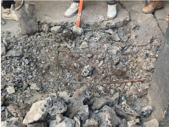
Imagen 21. Demolición del piso. FUENTE: Imagen propia.
