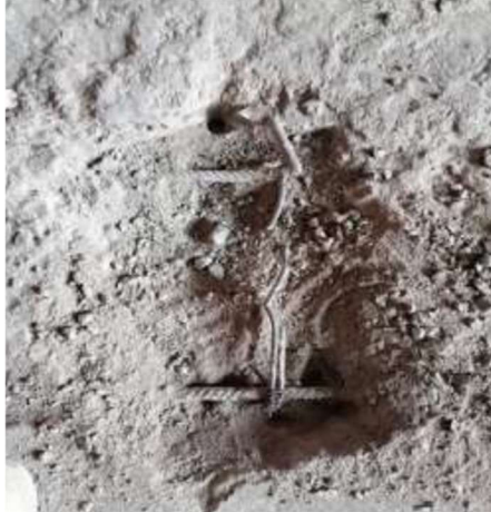
Imagen 25. Cala 2. FUEENTE: PC Constructores.
