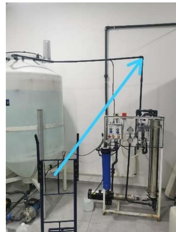
Fotografía 3. Conexiones y funcionamiento de Osmosis dentro de la Clínica Hemodiálisis Integral Ermita. FUEENTE: Imagen propia.
