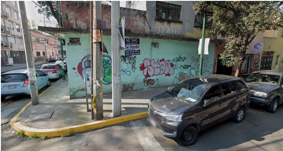
Imagen 9. Falta de rampas en vía pública. Google, Street view (2023).
