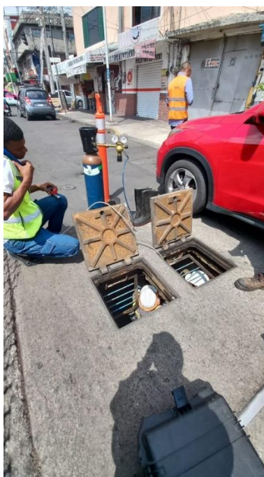
Figura 20. Sistema completo de inyección. Elaboración propia.
