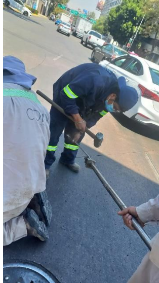
Figura 10. Armado del maneral telescópico. Elaboración propia.
