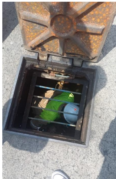
Figura 16. Trabajadores que colocarán el inyector. Elaboración propia.
