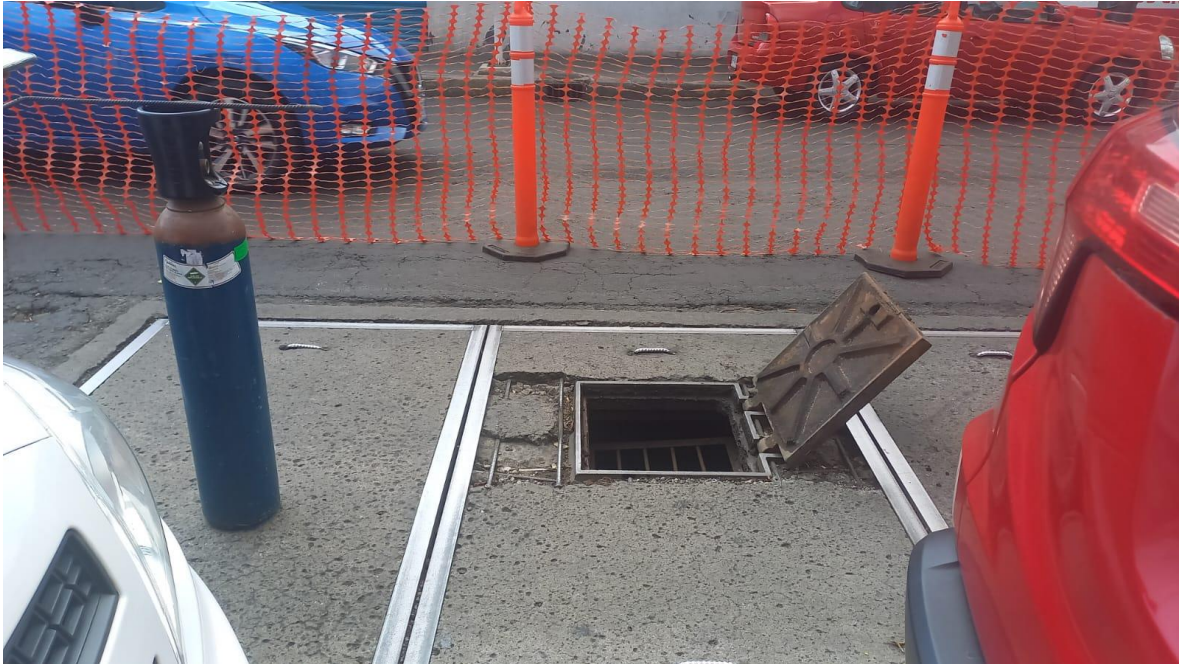
Figura 13. Tapa de la caja y tanque de helio. Elaboración propia.
