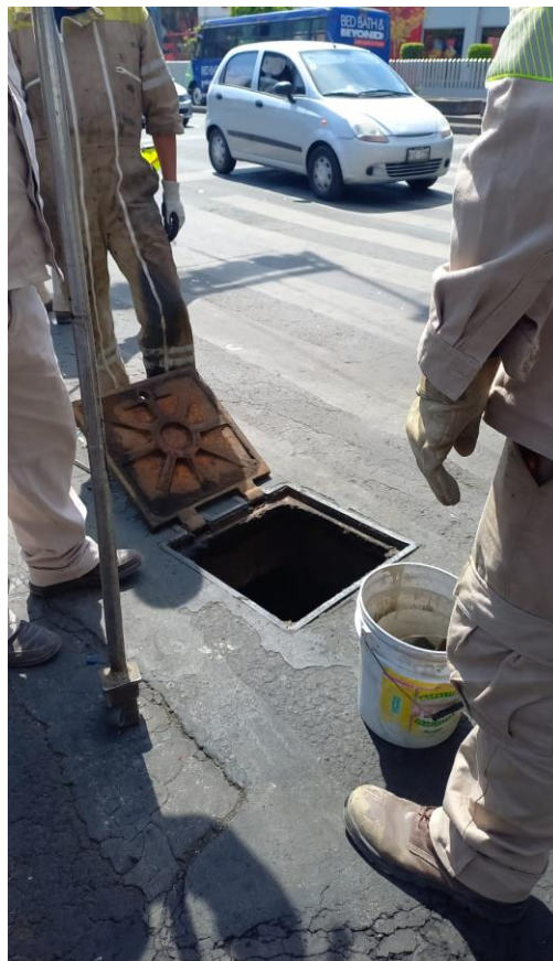
Figura 9. Caja de registro abierta para inspección. Elaboración propia.
