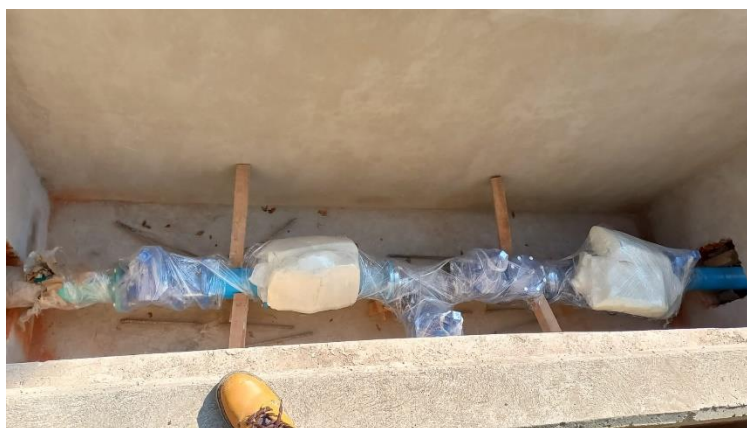
Figura 3. Caja de medición y control de sector. Elaboración propia.
