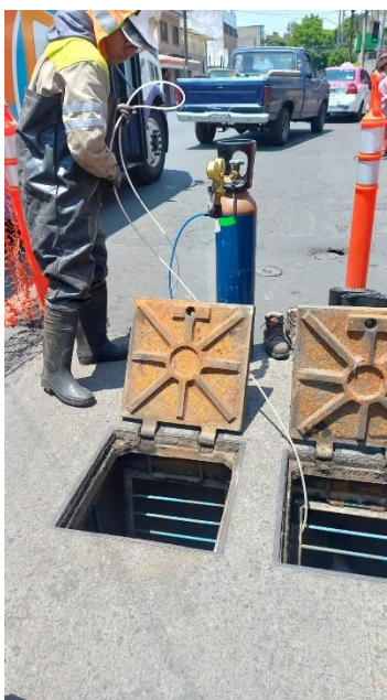
Figura 25. Retiro del tanque e inyector a la entrada al sector. Elaboración propia.
