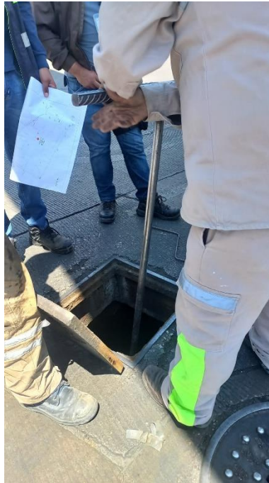
Figura 11. Operación del maneral telescópico.
