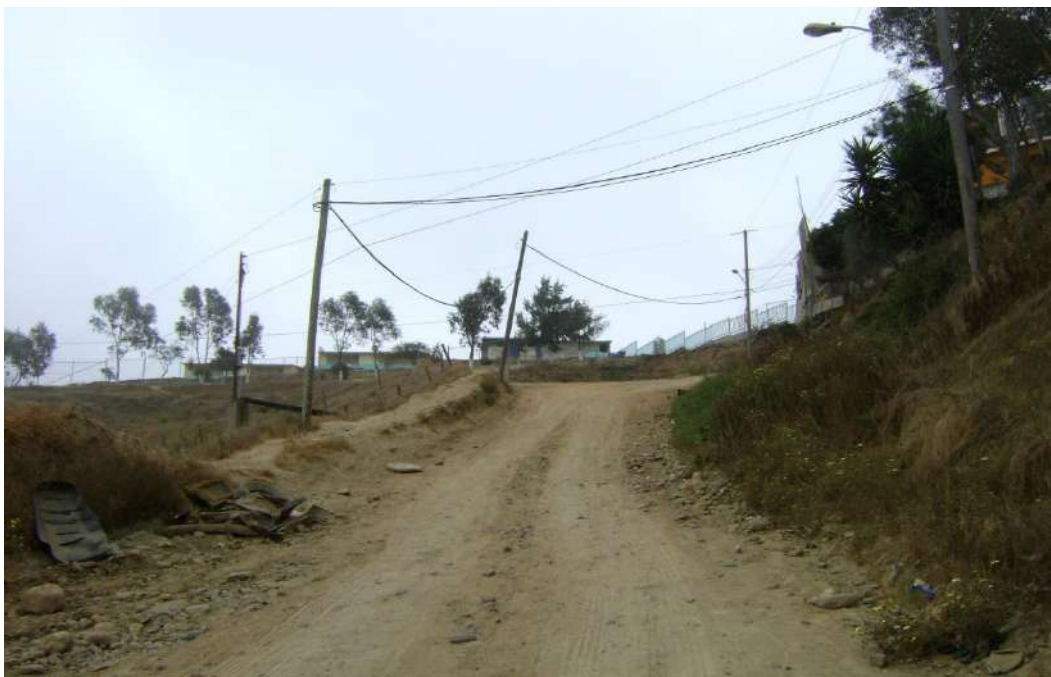
Pérez, V. (2009). Camino de terracería de acceso a las escuelas . (Foto 7). Pedregal de Santa Julia, Tijuana, Baja California, Méx.
