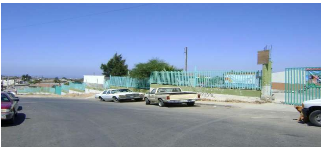
Pérez, V. (2009). Camino pavimentado de acceso a las escuelas . (Foto 8). Pedregal de Santa Julia, Tijuana, Baja California. Méx.
