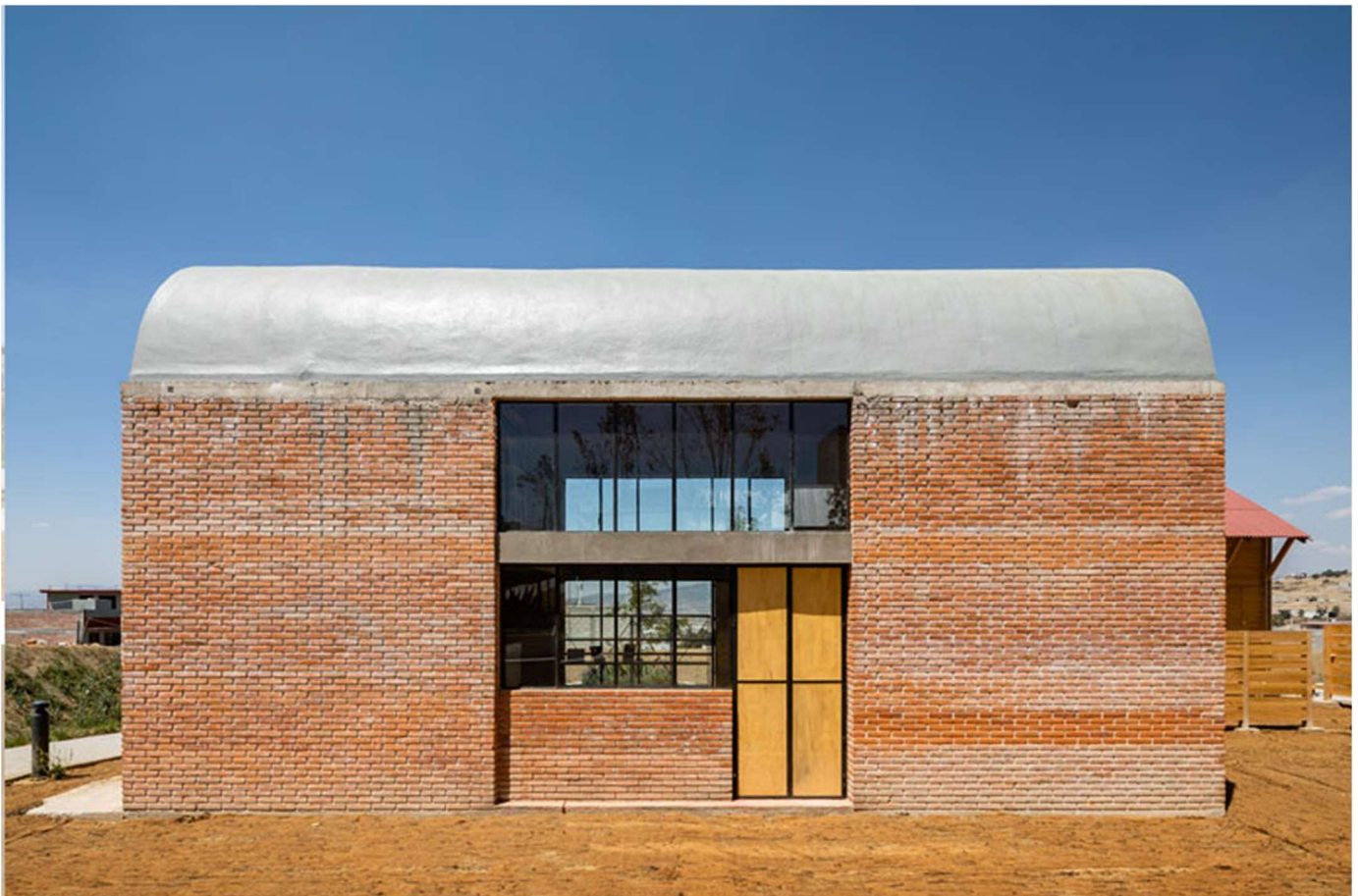
En Apan, Hidalgo, "Laboratorio de Investigación y Experimentación Práctica de Vivienda INFONAVIT". Proyecto Frida Escobedo Taller de Arquitectura. Fachada lateral. Imágenes de Rafael Gamo, Vía página oficial Frida Escobedo Taller Arquitectura.
