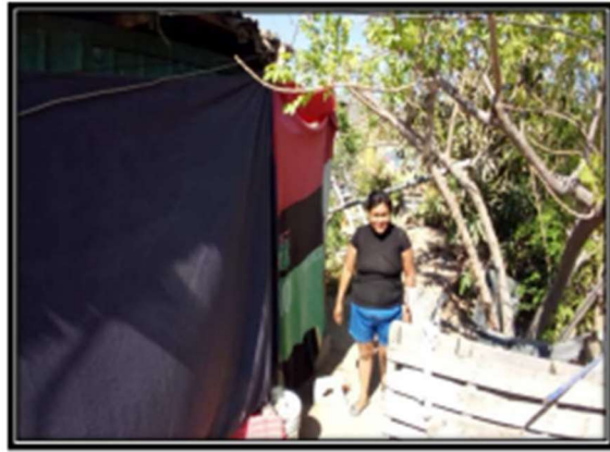
La beneficiaria nos muestra las areas de la casa donde usa telas para divisiones y para pared de interperie. Utiliza sábanas para la division del baño. Lo que no permite la privacidad de ella y de sus hijas.
