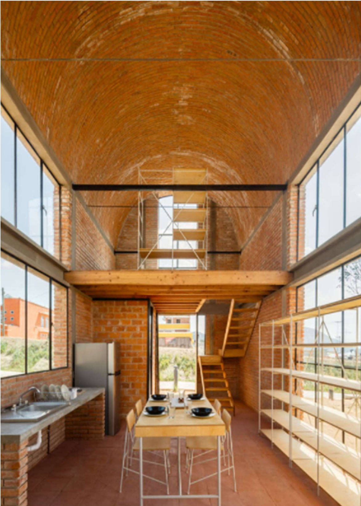
En Apan, Hidalgo, "Laboratorio de Investigación y Experimentación Práctica de Vivienda INFONAVIT". Proyecto Frida Escobedo Taller de Arquitectura. Vista interior del área de cocina – comedor y recámara. Imágenes de Rafael Gamo, Vía página oficial Frida Escobedo Taller Arquitectura.
