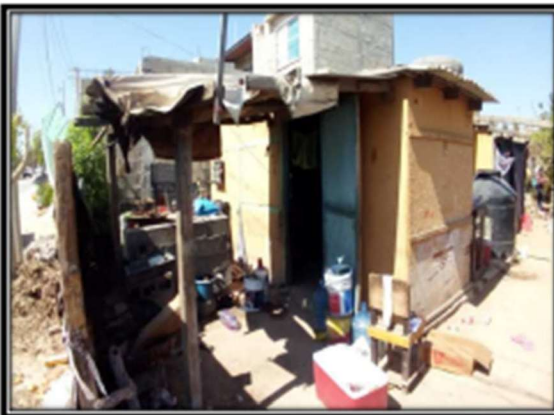
Imagen del acceso de la vivienda, el cual tambien es el unico cuarto que usan como dormitorio los usuarios, el cual carece de diseño estructural y diseño arquitectonico. No se aprecia ningun detalle estructural ni castillos ni cadenas. El deterioro de la parte exterior daña las condiciones del interior, lo que no brinda seguridad al usuario. No cuentan con area de cocina, ni comedor.
