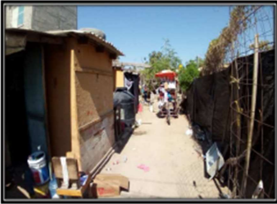
Como se observa en la imagen el acceso de la vivienda es de terraceria, asi como, la falta de bardas perimetrales y piso firme, se observa barda y paredes de madera y malla con plastico negro. Reflejando las condiciones, en las cuales se encuentra la vivienda.
