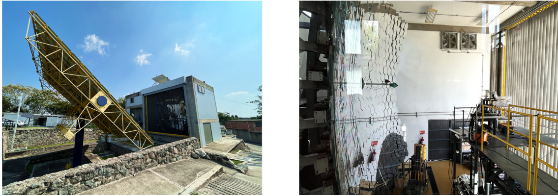
Figura 2.11: Horno solar del Instituto de Energías Renovables de la UNAM. A la izquierda, vista exterior, helióstato y atenuador abierto; a la derecha, interior del edificio, concentrador y mesa de experimentos
