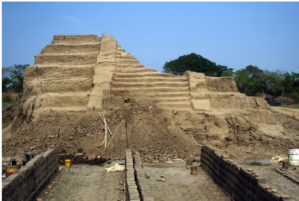
Figura 12: Fachada de la pirámide recién excavada en 2008. (Fuente: Toriz, 2020)
