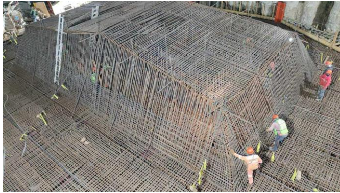
Imagen 1. Armado de acero para zapata de cimentación.
