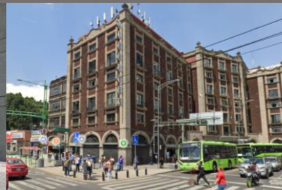
Estación Metro Salto del Agua.
