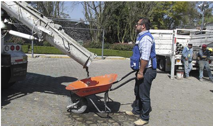
Imagen 58. Recolección de la mezcla para la realización de pruebas.
