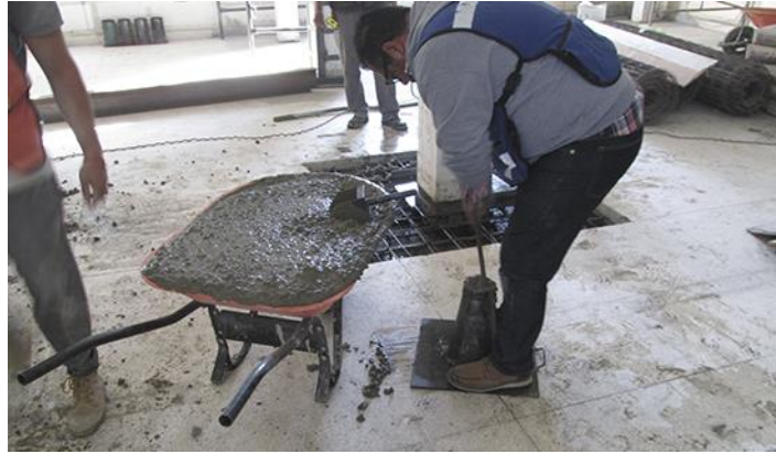
Imagen 48. Prueba de revenimiento en mezcla de concreto para colado de zapatas.
