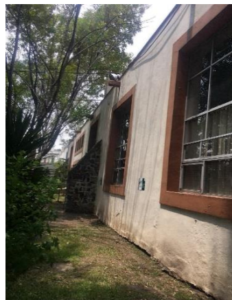
Imagen 24. Exterior: Vanos y contrafuertes de apoyo en los muros estructurales.
