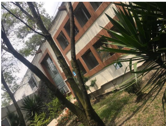
Imagen 23. Exterior: Fachada oeste y acceso secundario.
