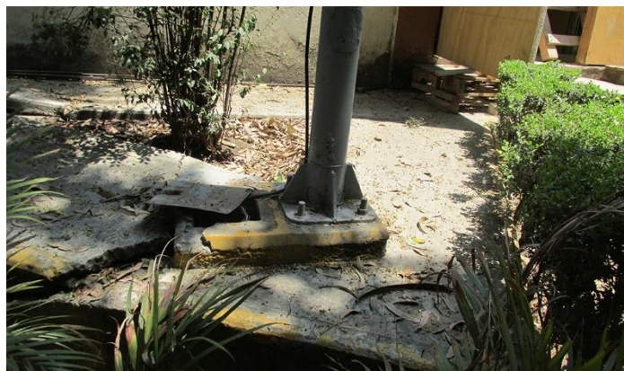
Imagen 28. Reparación de guarniciones, retiro de vegetación nociva.
