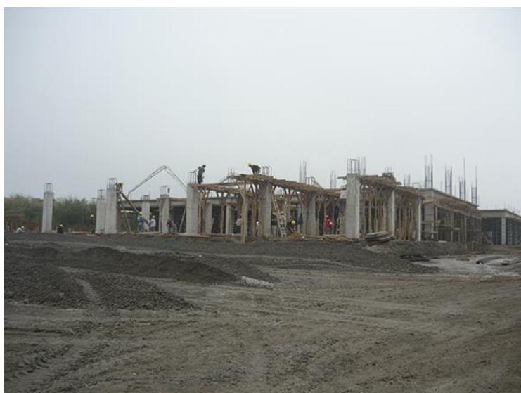
Imagen 5. Construcción de equipamientos para la salud pública.
