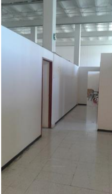
Imagen 33. Ala sur, condiciones anteriores a los trabajos de remodelación.
