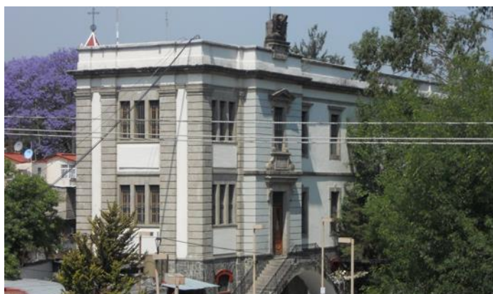
Imagen 13. Antiguo edificio de la Escuela Militar de Aspirantes.
