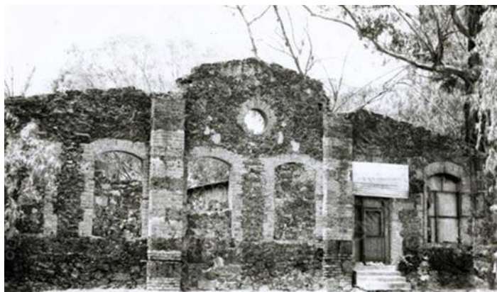
Imagen 11. Edificio anexo a la antigua Fábrica de San Fernando en condiciones deplorables.
