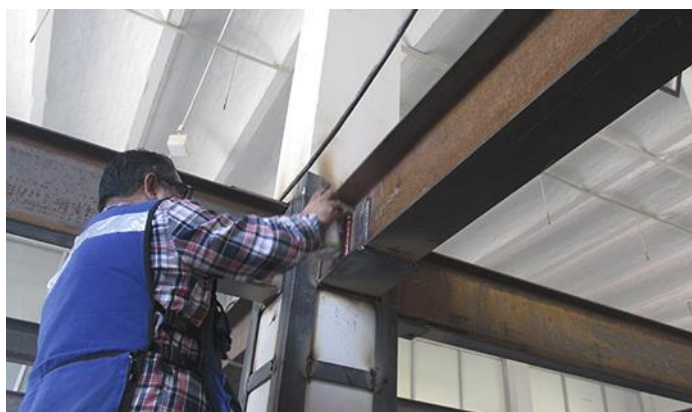
Imagen 54. Aplicación de líquido revelador en uniones estructurales.
