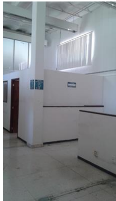
Imagen 36. Espacios de trabajo del ala norte, se aprecian confinamientos por muros divisorios y doble altura.
