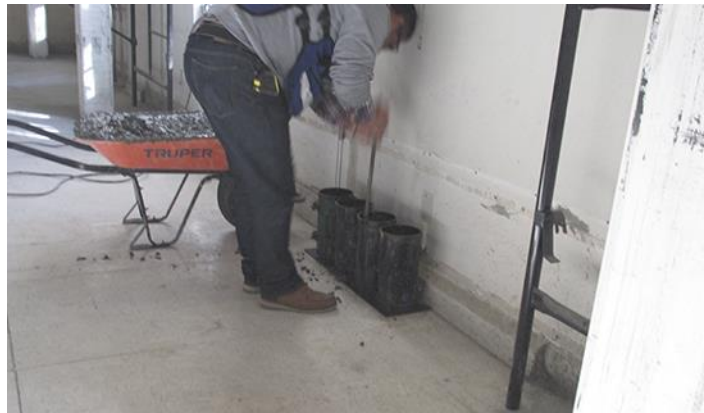
Imagen 49. Muestreo de concreto fresco para pruebas en laboratorio.
