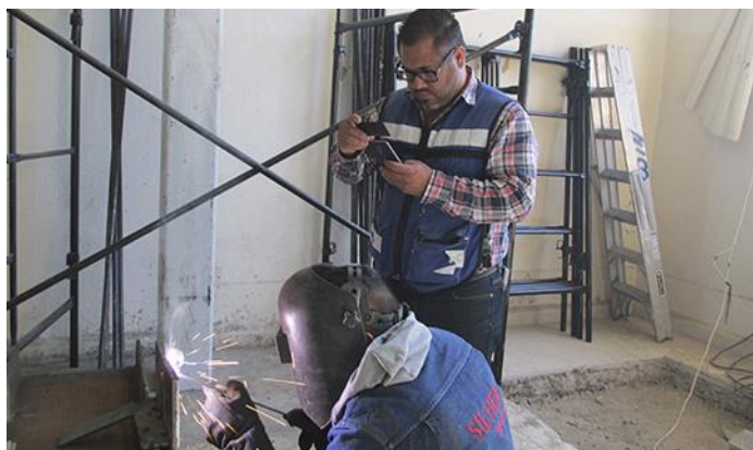
Imagen 53. Verificación de las habilidades del soldador.
