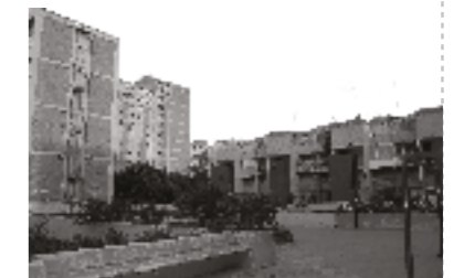
Conjunto Habitacional Integración Latinoamericana. FOVISSSTE. 1976. Tipologías: Departamental. 1460 viviendas.
