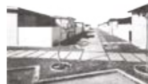
Unidad Mario Moreno "Cantinflas". 1953. Tipologías: Casas unifamiliares.
