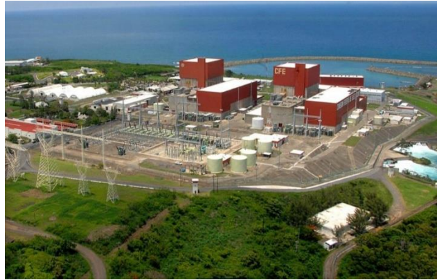
Figura 12. Vista aérea de la CNLV.
