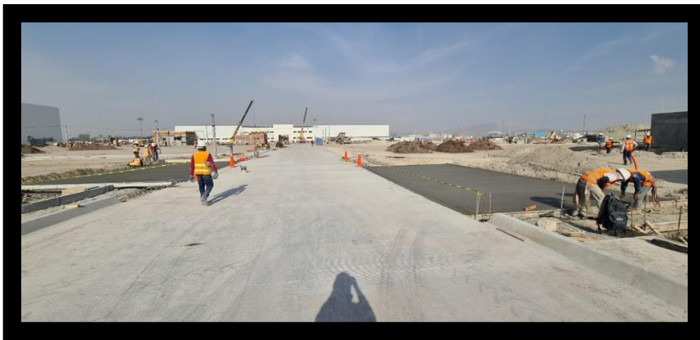
Bahías de estacionamiento recién coladas ubicadas en la vialidad del Complejo Logístico.
