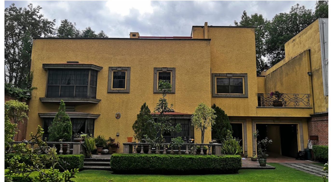
Fotografía 1 - Levantamiento fotográfico para análisis de Sitio. Imagen muestra fachada interior del proyecto Propiedad equipo Charpente Interiorismo y Carpintería.
