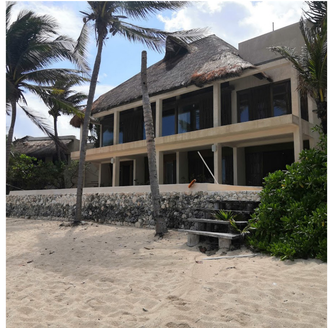
Fotografía 5 - Imagen muestra levantamiento fotográfico en visita de sitio Propiedad equipo Charpente Interiorismo y Carpintería
