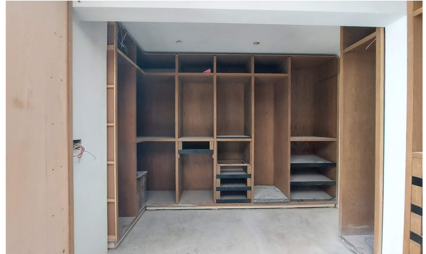
Fotografía 8 - Imagen muestra proceso instalación carpinterías closets de recámara principal Propiedad equipo Charpente Interiorismo y Carpintería.
