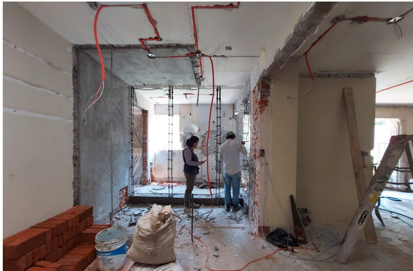
Fotografía 7 - Imagen muestra proceso desmantelamiento de closets en recámara principal Propiedad equipo Charpente Interiorismo y Carpintería.
