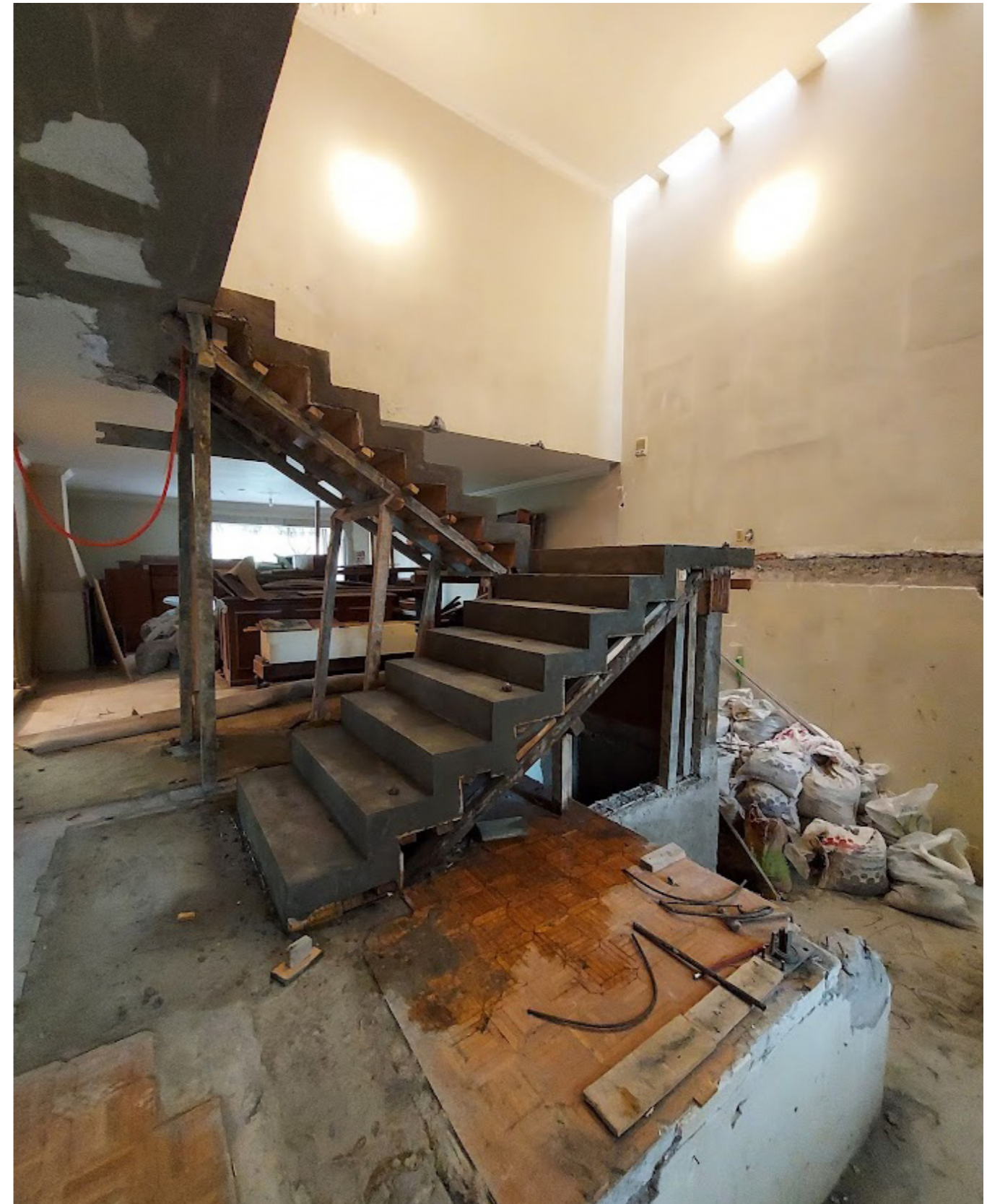
Fotografía 4 - Imagen muestra vestíbulo y escaleras en proceso de remodelación Propiedad equipo Charpente Interiorismo y Carpintería
