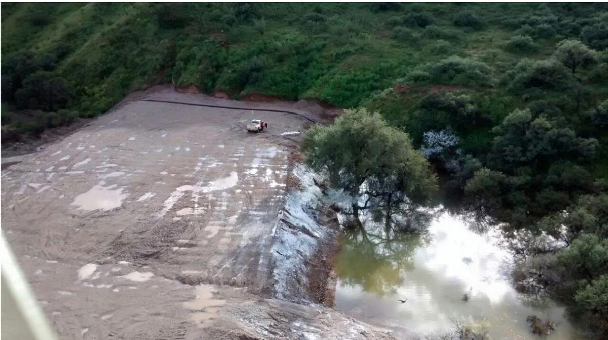
Figura 6. Aplicación de Cal como medida para la neutralización del lixiviado.
