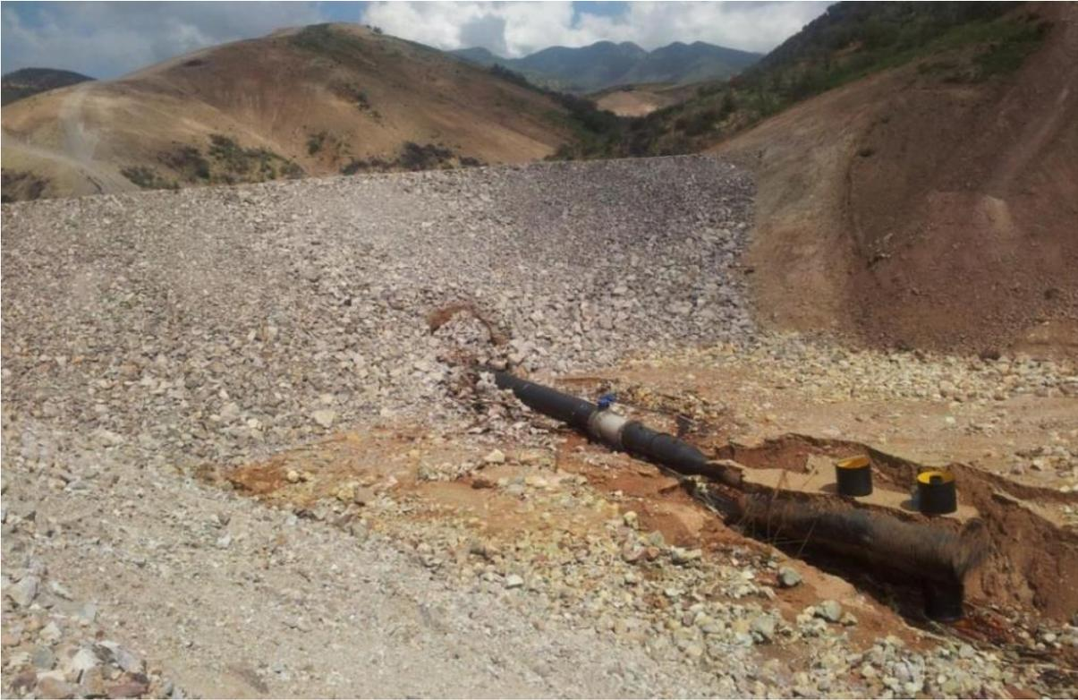
Figura 1. a) Represo poniente, zona de erosión por donde se produjo el derrame.
