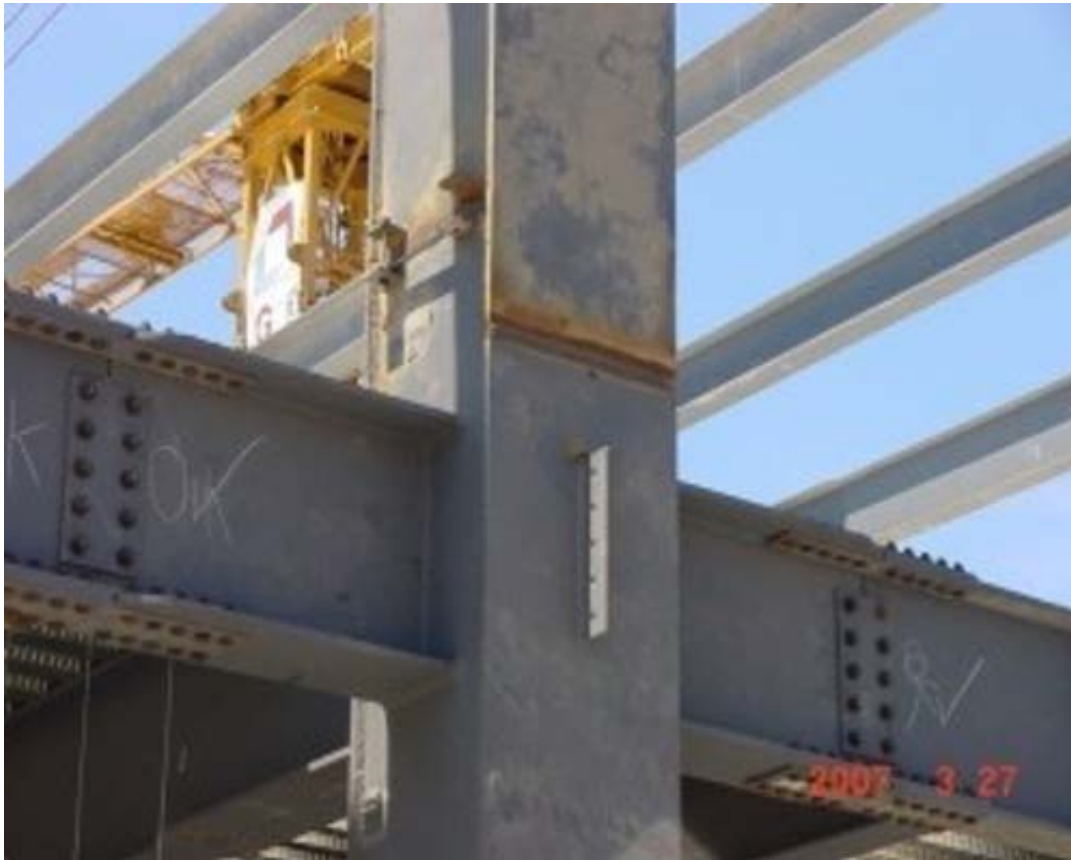
Figura 43. Conexión tipo árbol entre columna y viga
