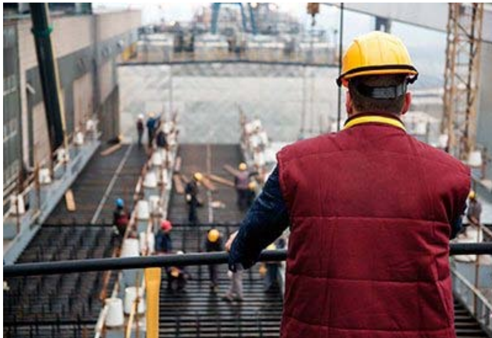
Figura 61. Supervisión de obra.
