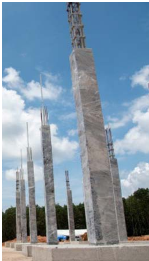
Figura 11. Columnas de concreto armado
