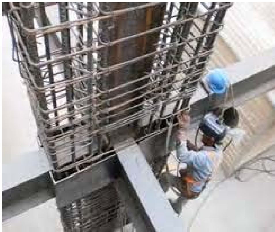
Figura 48. Columna mixta de perfil embebido y armado de acero de refuerzo en construcción.
