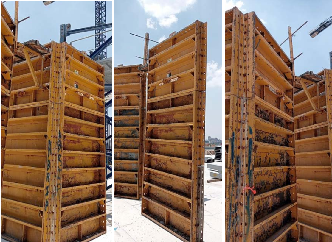
Figura 88. Cimbra metálica utilizada para las columnas.
