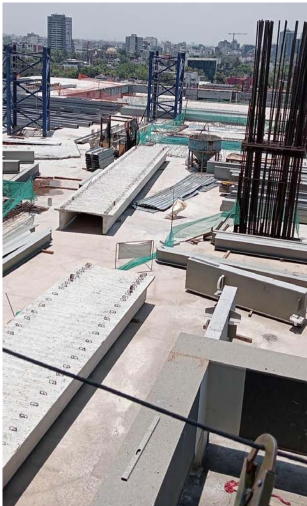
Figura 81. Armado de acero de refuerzo de columna junto a elementos estructurales pre-fabricados en el 8vo piso.
