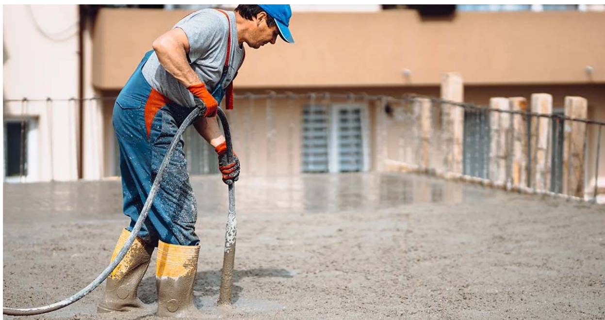
Figura 59. Vibrado de concreto en una losa.
