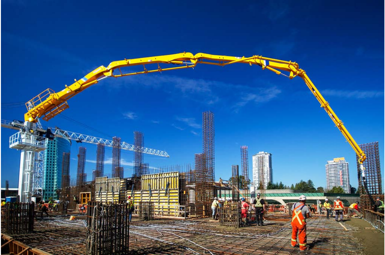
Figura 57. Placing-Boom en colado.
