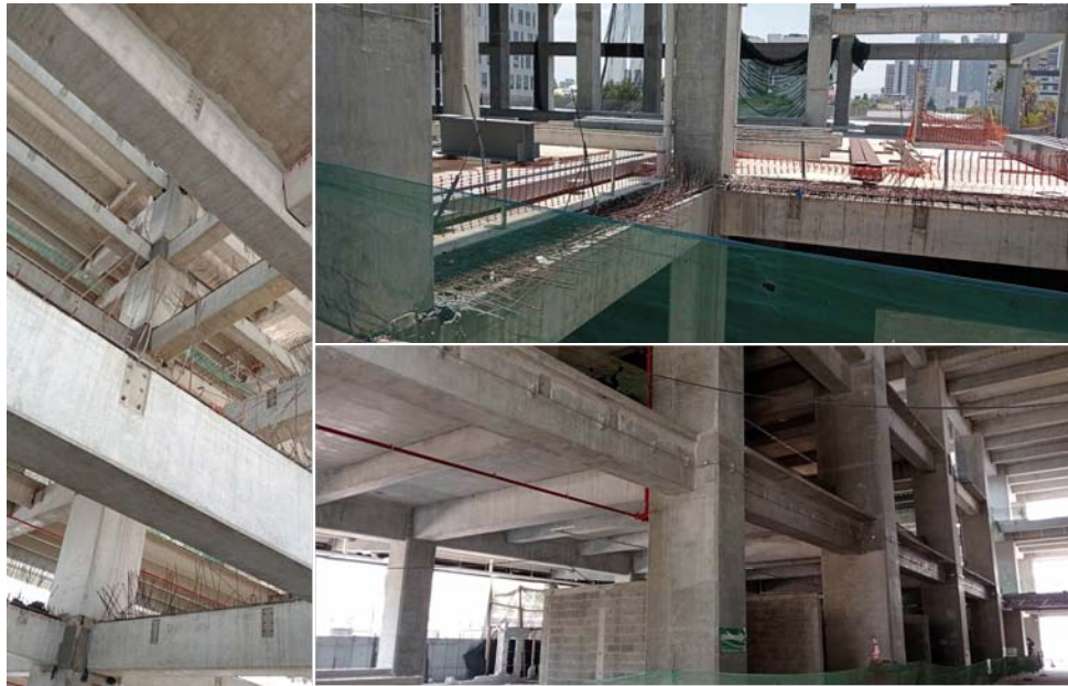
Figura 67. Columnas mixtas terminadas.
