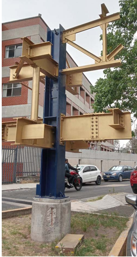
Figura 36. Árbol de conexiones, Facultad de Ingeniería Ciudad Universitaria, Universidad Nacional Autónoma de México.
