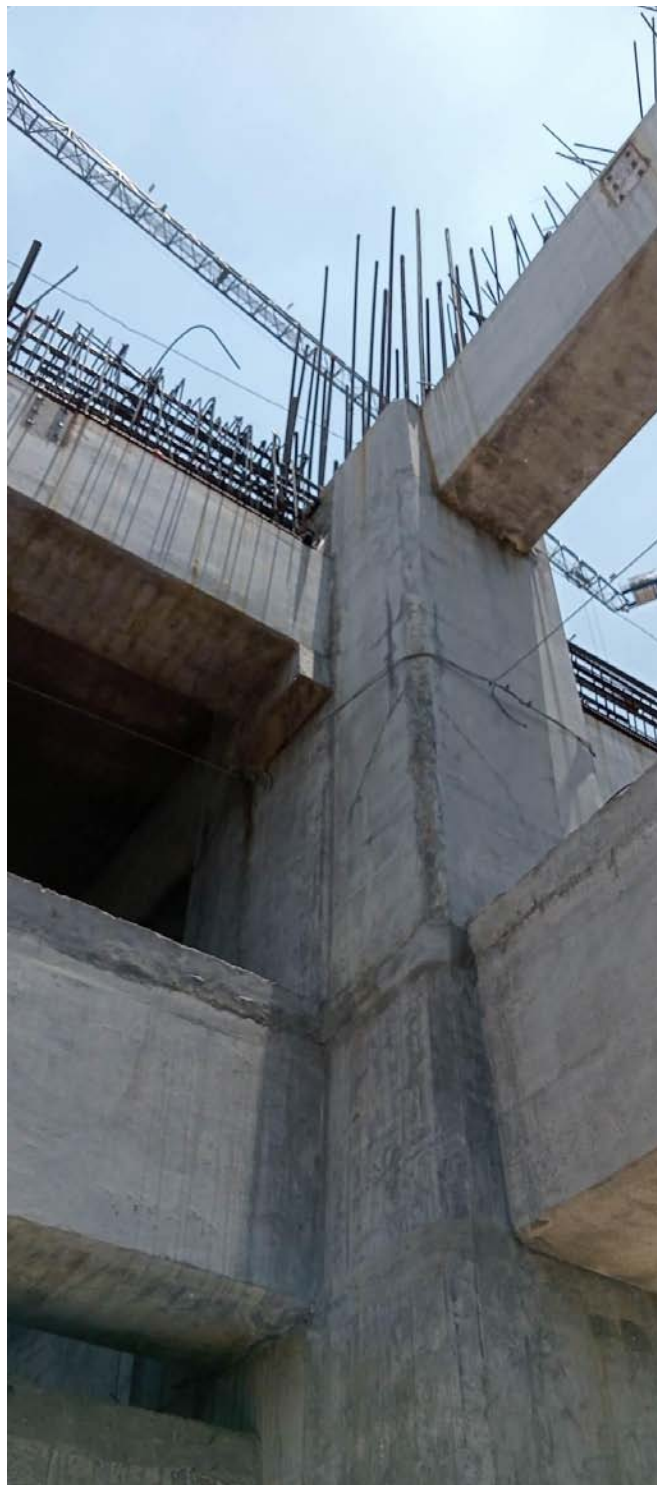
Figura 80. Acero de refuerzo de continuación sobre columnas ya terminadas.
