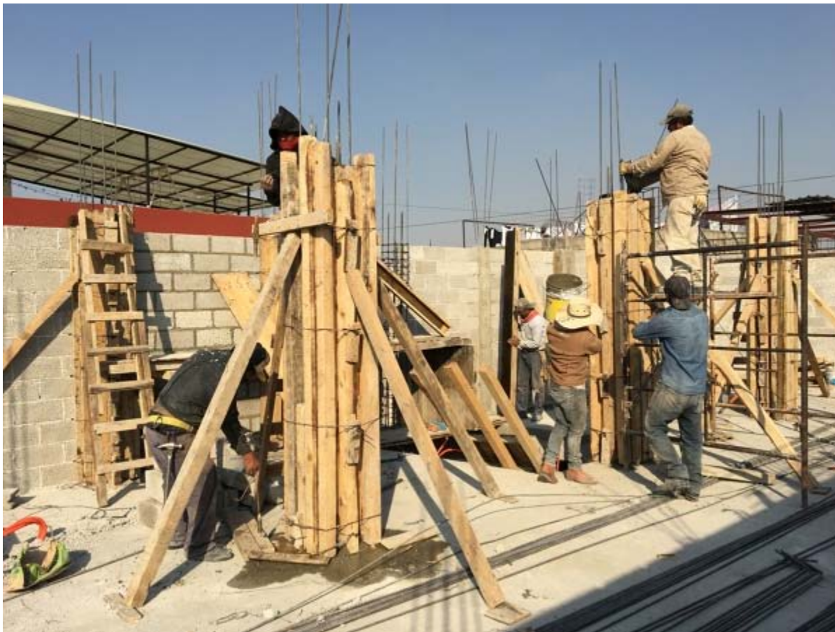
Figura 16. Cimbra de madera para columnas de área transversal cuadrada.
