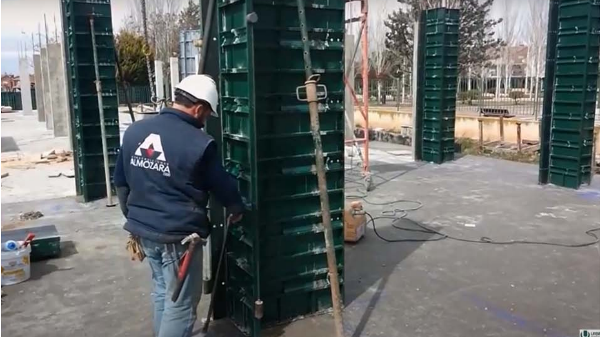
Figura 23. Colocación del plomo y apuntalamiento en cimbra metálica
