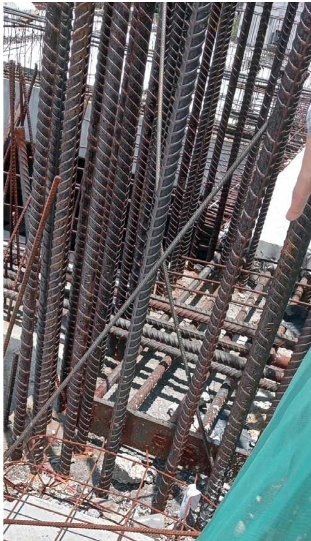
Figura 83. Armado de acero de refuerzo en nodo de una columna.
