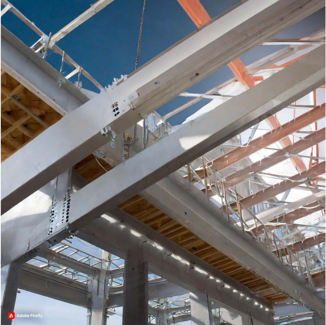
Figura 1. Estructuras compuestas en construcción.
