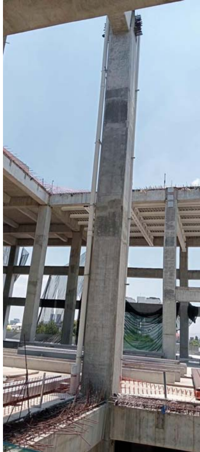
Figura 71. Columna terminada con altura de 3 entresijos.
