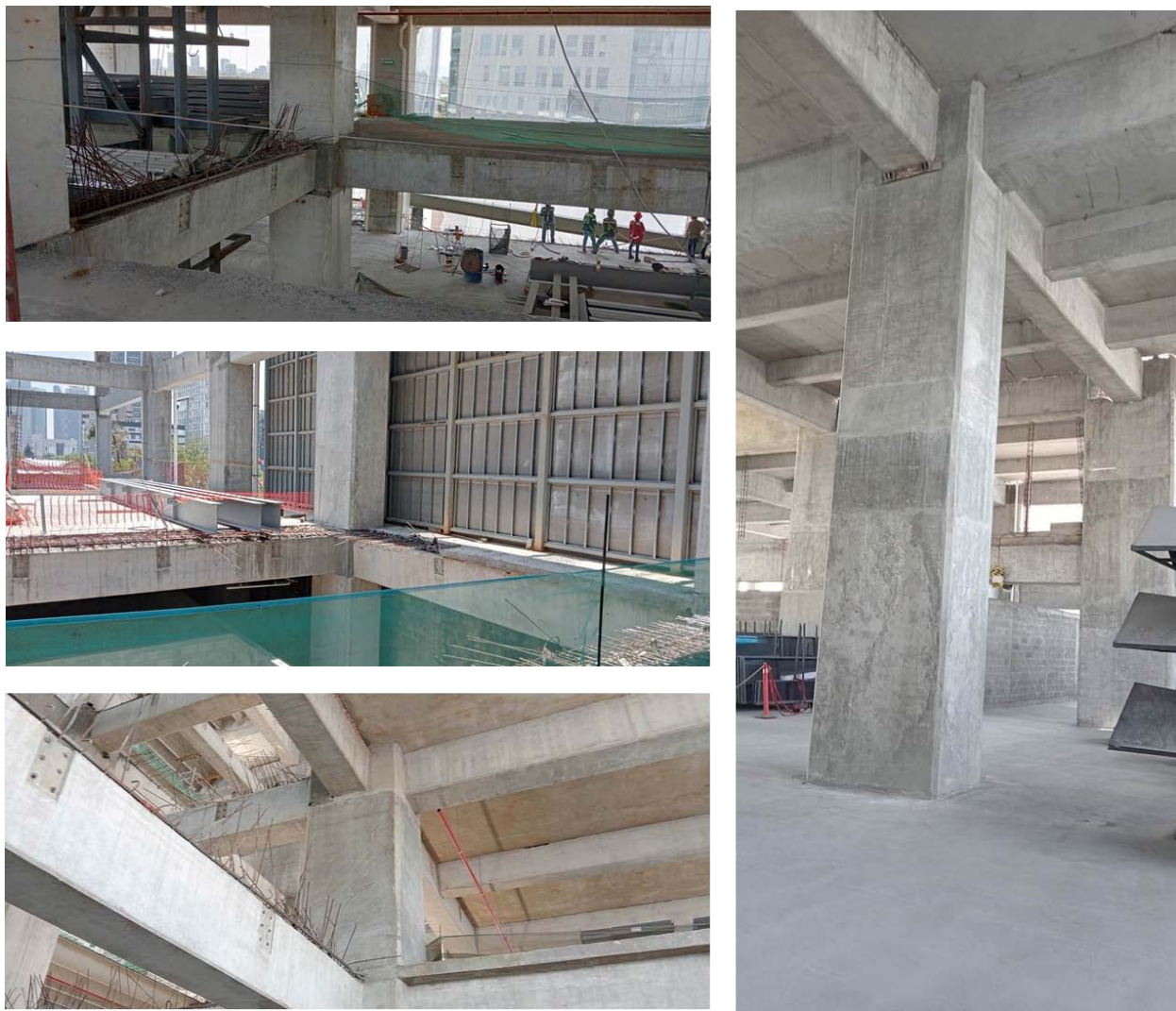
Figura 68. Columnas mixtas terminadas.
