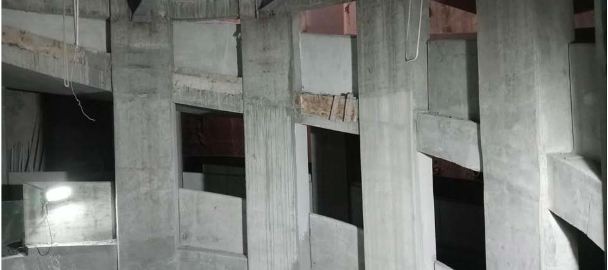
Figura 69. Columnas terminadas de los sótanos de estacionamiento.
