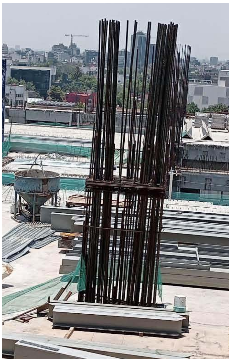
Figura 77. Acero de refuerzo en una columna mixta.
