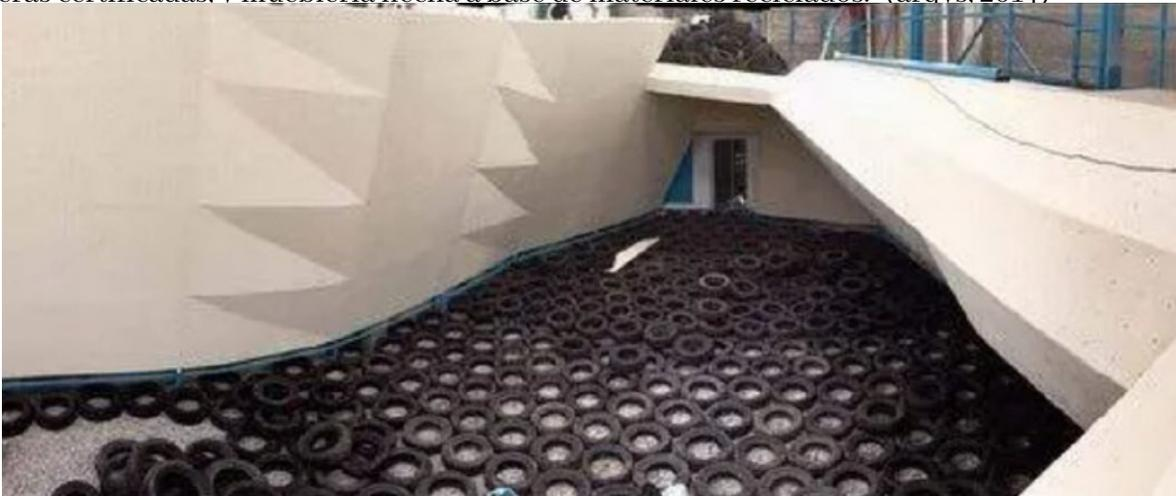
Imagen 25. Construcción de muros de escalada y relleno de colchón de seguridad. Fuente: Arqvs, 2021
