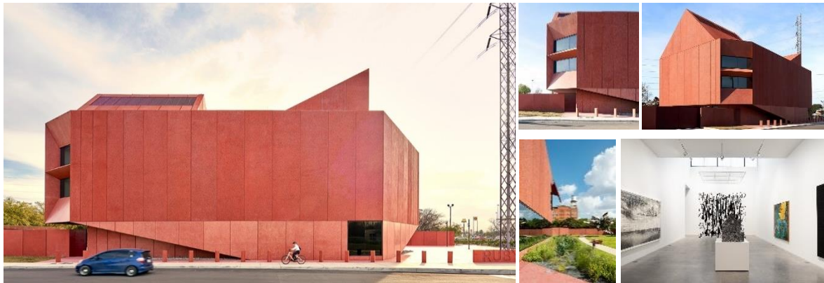
IMAGEN 16. Fachadas de recinto e interiores del centro cultural. Pintos, P. (15 de octubre de 2020). ArchDaily. Recuperado el 14 de enero de 2023, de Centro de Arte Contemporáneo Ruby City / Adjaye Associates: https://www.archdaily.mx/mx/948951/centro-de-arte-contemporaneo-ruby-city-adjaye-associates
