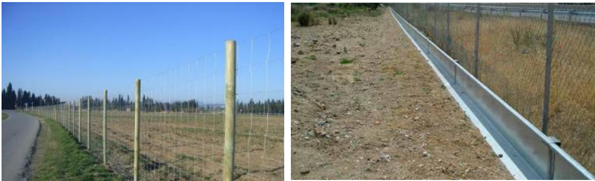
Figura 30 Tendido de malla ganadera (izq) y malla ciclónica con rodapié (der)
