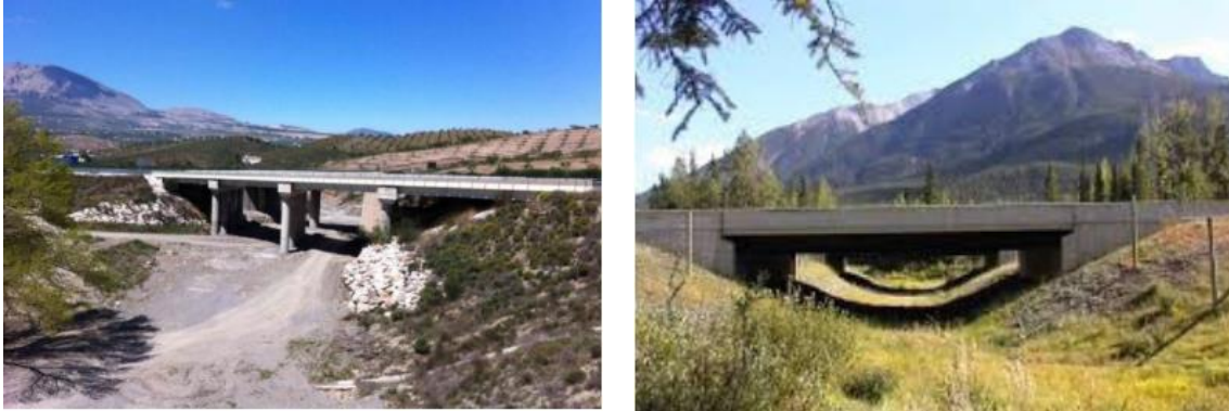
Figura 8 Puente carretero, ferroviario y losa funcionando como Paso Superior para Fauna (PSFA)
