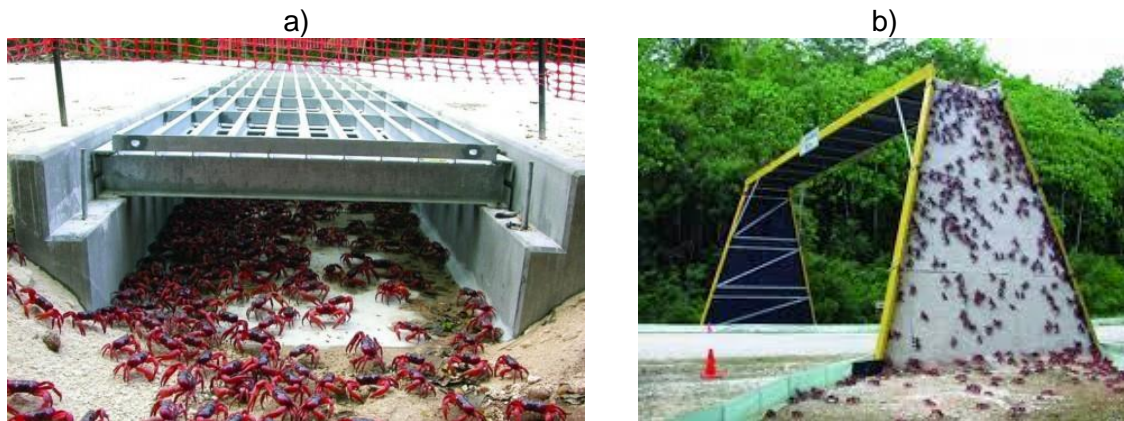
Figura 26 Pasos para cangrejos ( Brachyura ) Isla Navidad, Australia. a) Embebido en la carretera (PSFA) y b) Overpass desmontable (PIFA)
