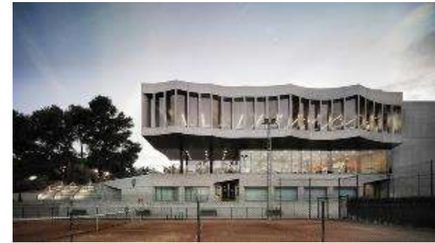
Edificio Social del Club Deportivo Stadium Casablanca 15
