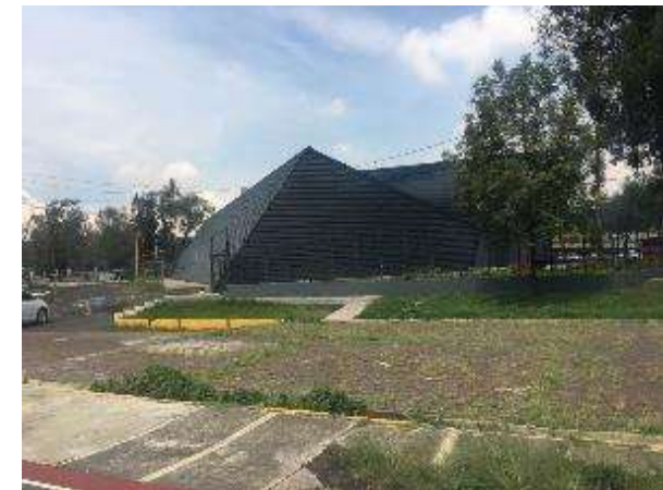
Fachada de la cubierta de la alberca en Deportivo Oceanía
