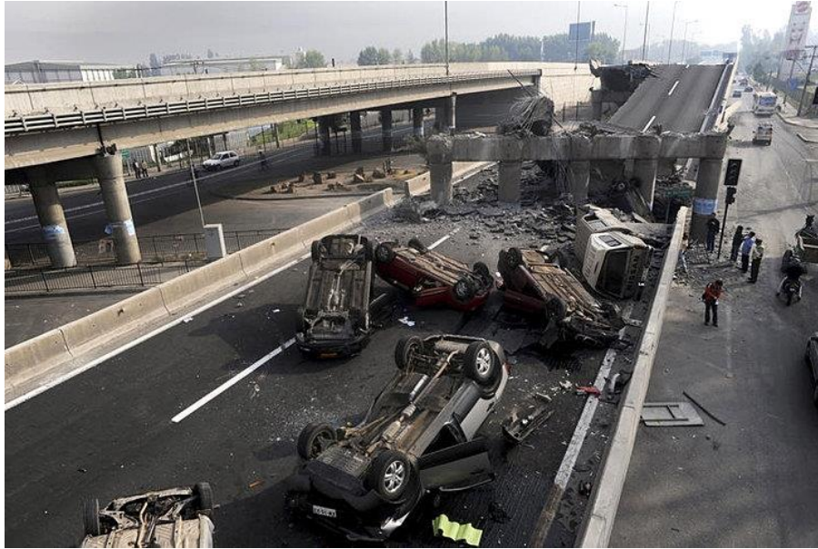
Figura 2.21 Colapso del puente Autopista Vespucio Norte.
