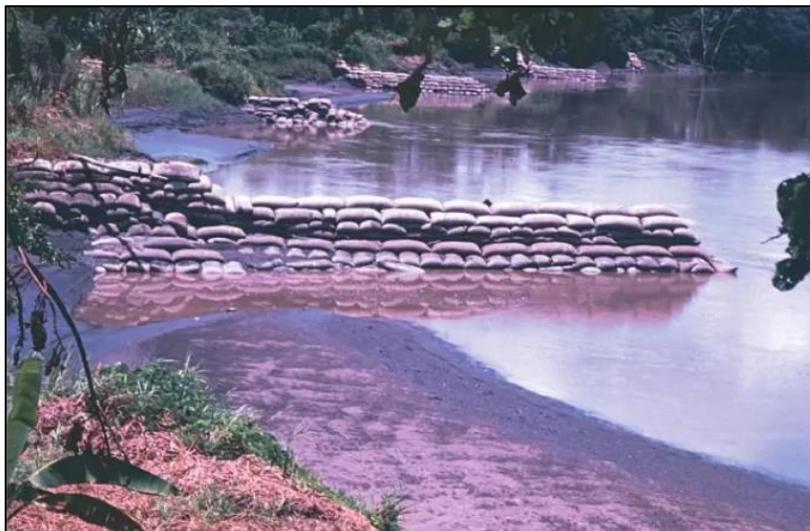
Figura 12 Ejemplo de Espigón formado por bolsa-cemento.
