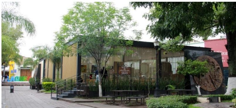
Imagen 23. Vista exterior del proyecto y su estructura. Tomada de s.a., s.f., Gobierno de Tlaquepaque https://www.tlaquepaque.gob.mx/tlaquepaque/desglose_post?id=1768
