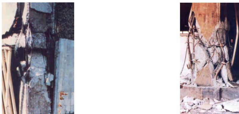
Figura 1.11: Daño en columnas de concreto reforzado tras los sismos de 1985 en la Ciudad de México (Rosenblueth y Meli, 1986).
