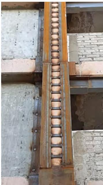
Figura 1.17: Encamisado de acero en proyecto de rehabilitación del sismo del 2017.
