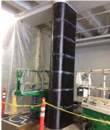
Figura 1.6: Encamisado de polímeros reforzados con fibras en una columna (Gkournelos et al., 2019).
