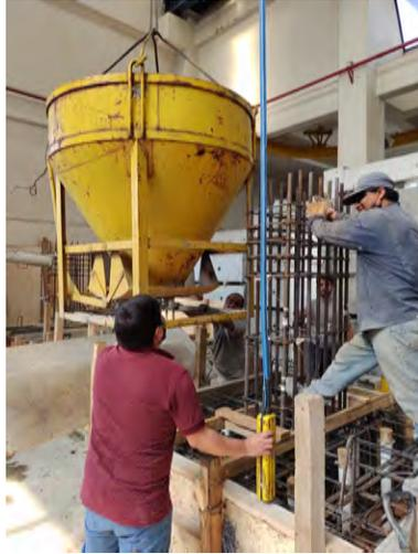
(a) Colocación del concreto en las zapatas.
