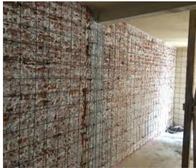
(a) Encamisado de muro de mampostería, tras daño sísmico en 2017 (Murcia-Delso et al., 2020).
