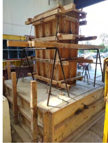
(b) Colocación del concreto en las columnas.
