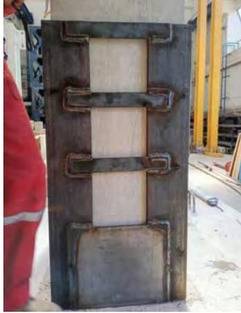
Figura 1.5: Encamisado con un entramado de acero formado por ángulos y soleras en una columna (Alcocer et al., 2023).
