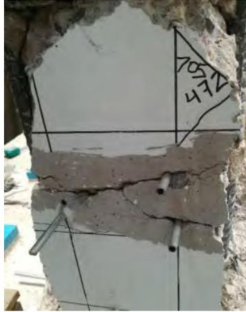
Figura 1.2: Preparación de un elemento para la inyección de grietas con resina epóxica (Alcocer et al., 2023).
