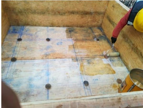
Figura 2.12: Colocación de aceite desmoldante en la cimbra (Alcocer et al., 2023).
