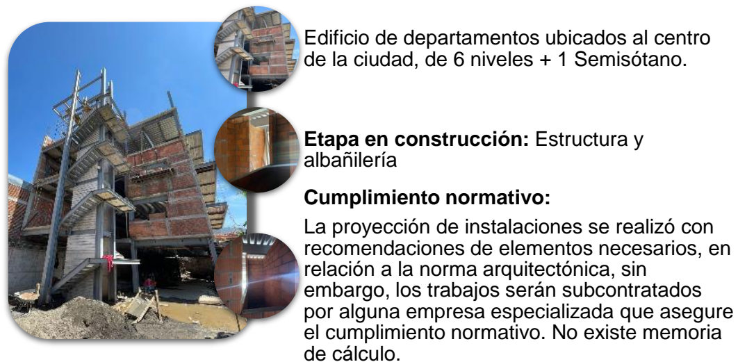
Figura 4. 2. Edificio "Central Living Morelos".
