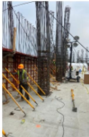
4.13 Cimbrado de elementos con cimbra modular, troquelada con polines y pies derechos en el segundo trepado del primer nivel
