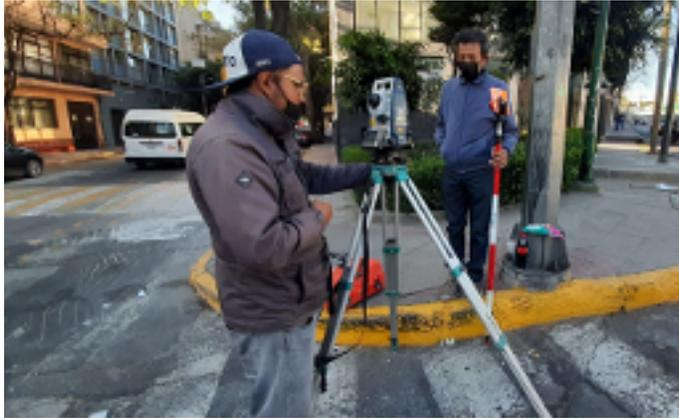
2.5 Levantamiento topográfico con estación total para trazo de proyecto de mejoramiento en av. constituyentes
