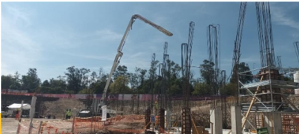
4.21 Bomba pluma para colado de columnas a una altura de 2.40 m
