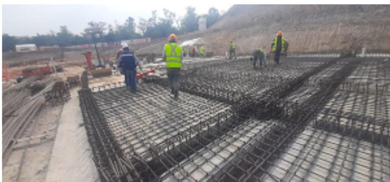
4.12 Armado de losa de cimentación, utilizando atados de varilla y habilitando los extremos en patio de habilitado
