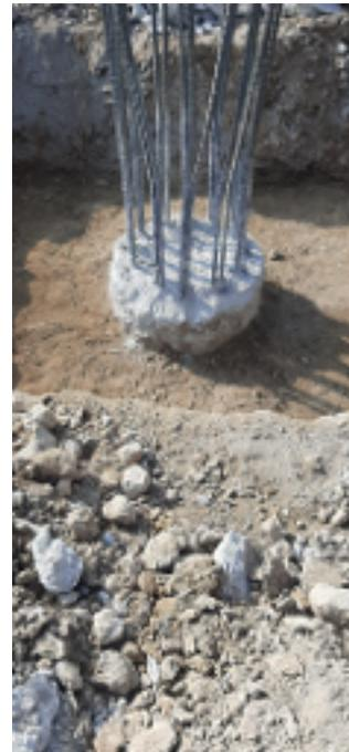
4.23 Izaje para perforación de pilas de cimentación a 28 m de profundidad e izaje de armado para pilas de cimentación.
