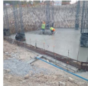
4.18 Colado de plantilla para desplante de acero para losa de cimentación
