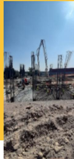
4.22 Cuadrilla específica para colado de plantilla y desplante de losa de cimentación
