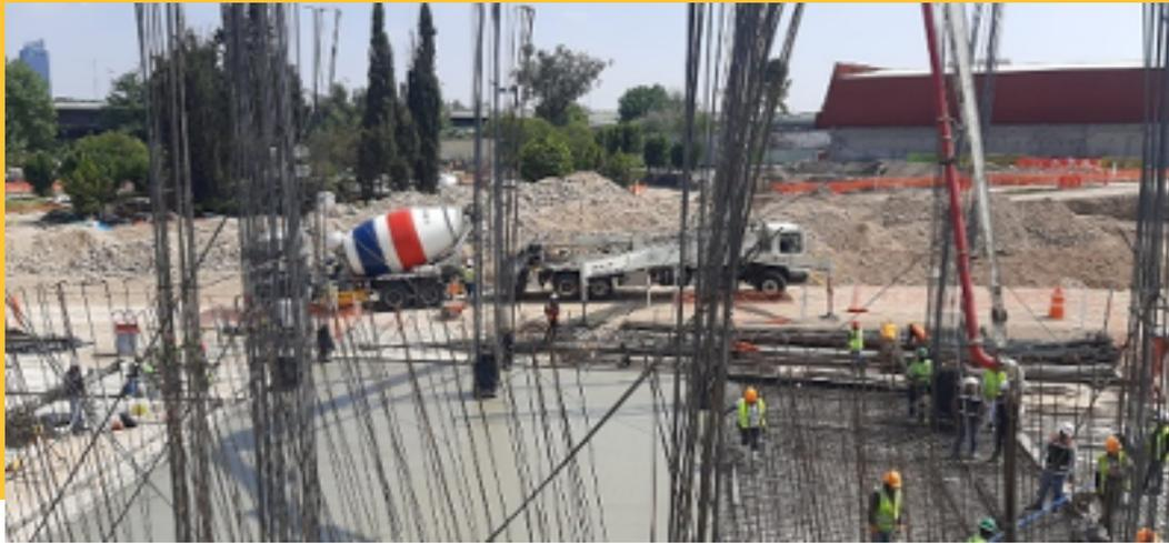
4.19 Colado de losa de cimentación con bomba pluma, concreto F'C 300
