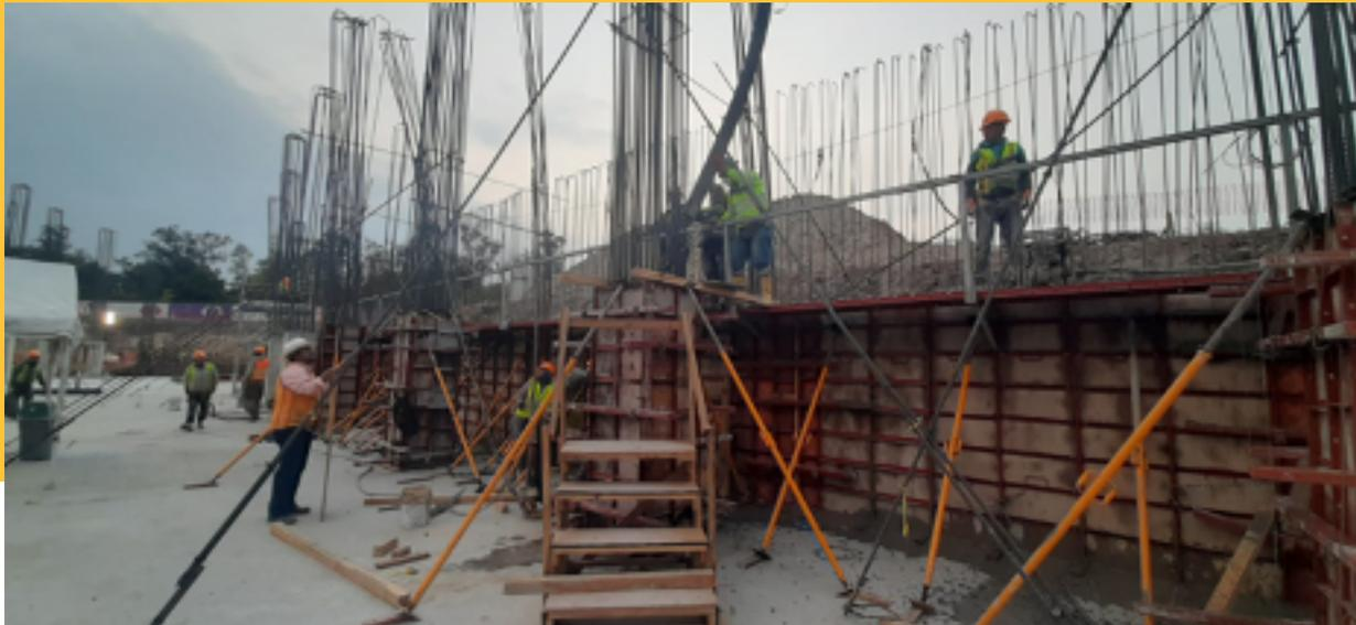
4.15 Trabajos de cimbrado de muro a 2.40 m, con elementos prefabricados se utilizó un concreto f/c 400 kg/cm<sup>2</sup> con bomba pluma
