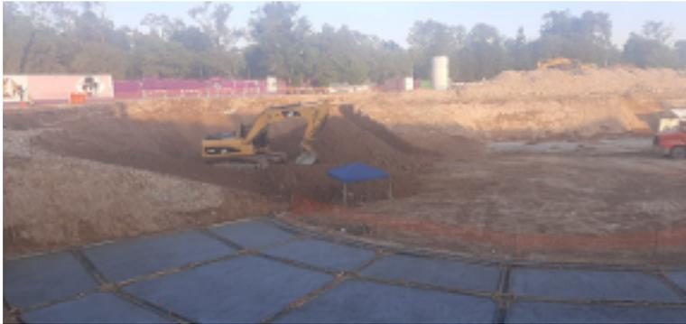
4.3 Preparación de terracerías para colado de plantilla de cimentación en edificio pc-02c
