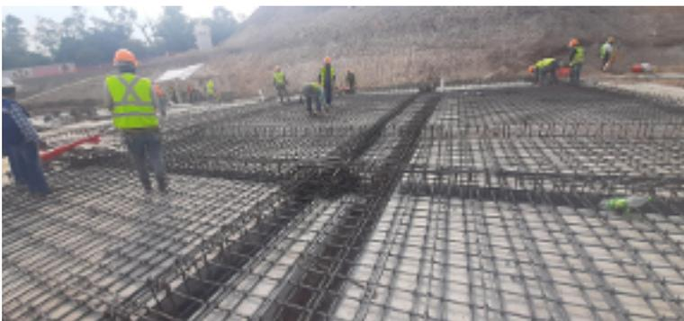
4.4 Armado de losa de cimentación en edificio pc-02c
