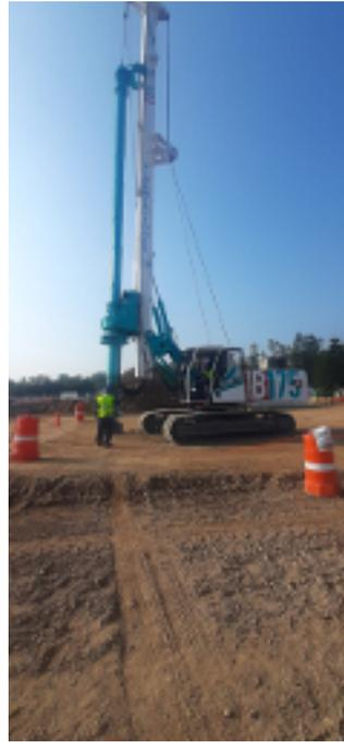
4.6 Preparación para perforación de pilas de cimentación
