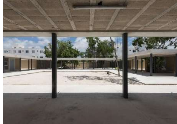
Imagen 16. Columnas metálicas del pórtico
