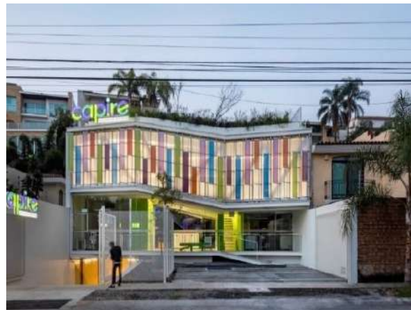
Imagen 18. Fachada principal de la guardería
