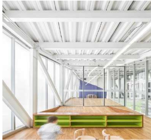
Imagen 26. Entrepiso de losa-cero
