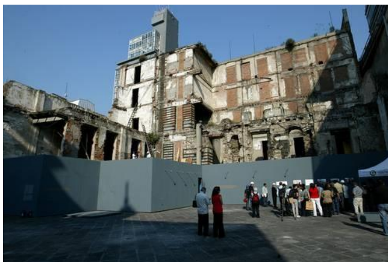
Nota. Vista posterior de la fachada en ruinas, años después del sismo de 1985. (García, 2010)
