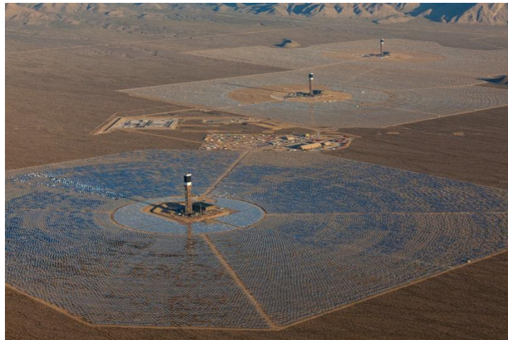
Figura 7. Planta solar Ivanpah [18]
