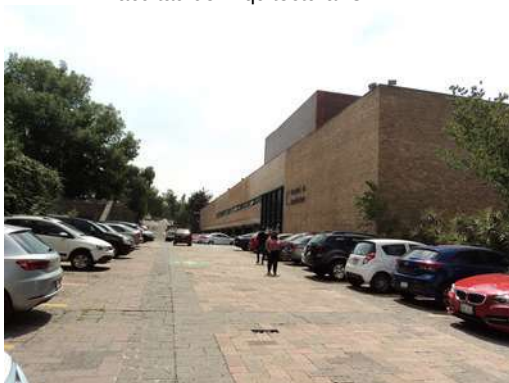
Gráfico 9. Fotografía fachada de la Facultad de Arquitectura. UNAM
