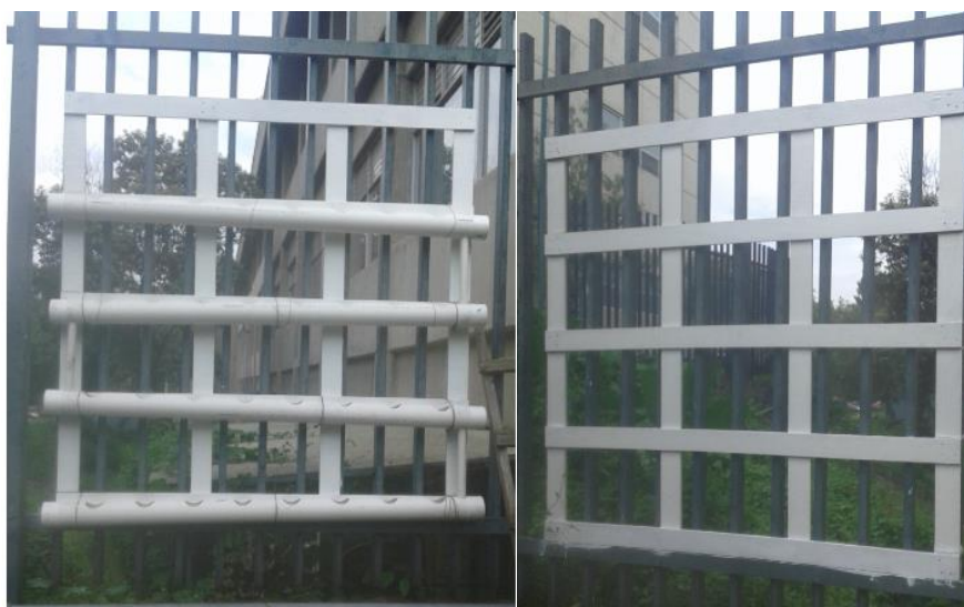
Figura 11. Colocación de bastidor y tubos de PVC.
