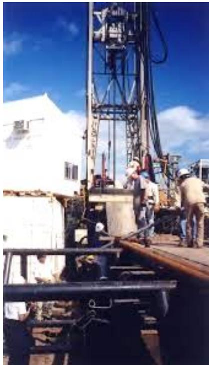
**Fig. 34** Se muestra el equipo para la perforación con corte de núcleos.
