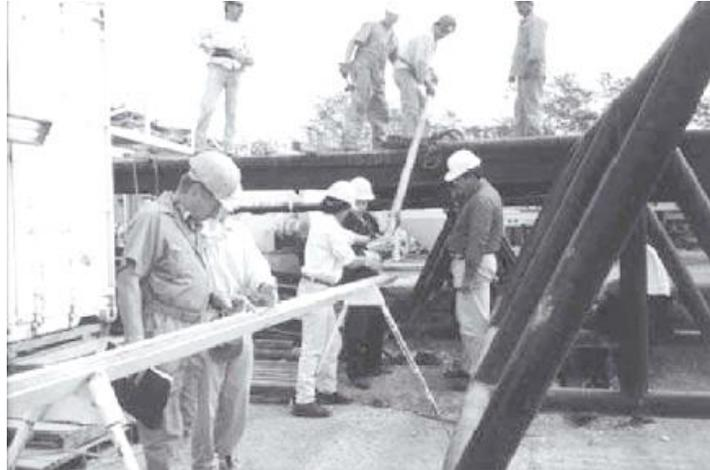
**Fig. 11** Se ilustra la operación de recuperación de núcleos en la Hacienda Yaxcopoil-1 (Urrutia *et al.*, 2011)
