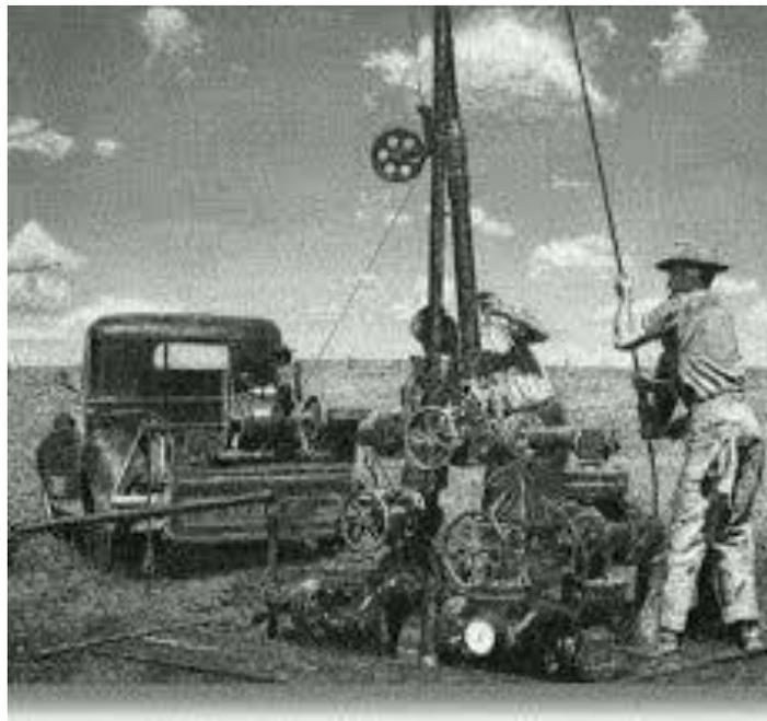
**Fig. 10** Se ilustra el primer equipo para la toma de registros eléctricos (Comunidad Petrolera – CPe, 2020)<sup>9</sup>.
