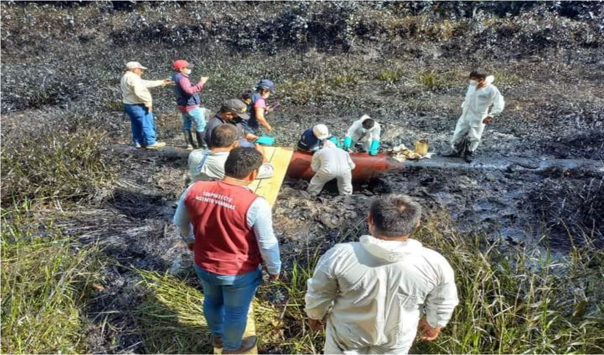
Reparación en Oleoducto Norperuano km 41+ 833, año 2014. Fuente: Marlita Salinas
