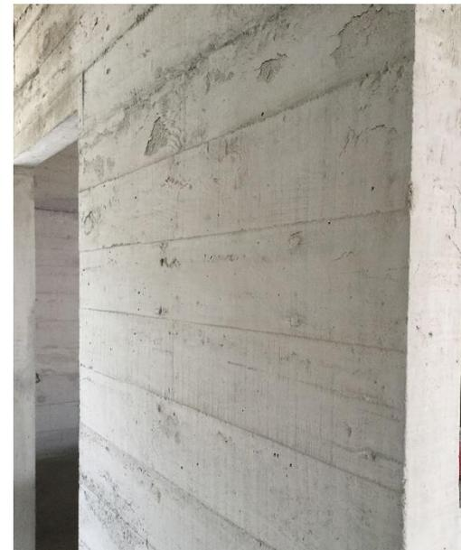
IMAGEN 6.1.2 muro de concreto armado.
