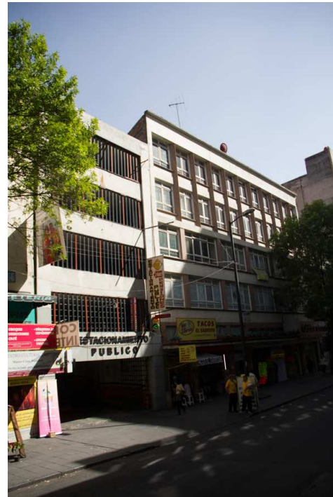
46 Actualmente locales comerciales.
