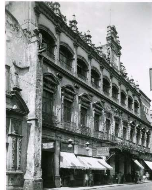
41 Fachada de Teatro Colón, 1920.
