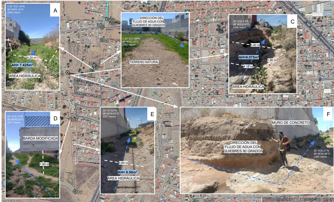
Figura 174. Imagen Satelital Google Earth con Red Hidrográfica Natural, Fotografías A, B, C, D, E Y F: ilustran que esta zona se ha modificado para la construcción de un canal con condiciones urbanas como lo son muros y bardas e incluso viviendas como límites para redireccionar el flujo del agua que escurre de las calles, y proviene del cauce principal.
