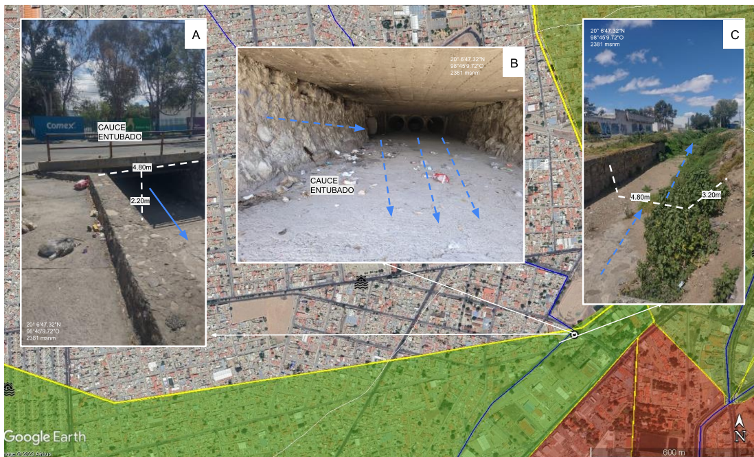
Figura 180. Imagen Satelital Google Earth con Red Hidrográfica Natural Fotografía A: se observa la salida del cauce entubado, Fotografía B: se observan dos corrientes entubadas una que viene del norte y otra que sale del este, el flujo de ambas se conduce por el canal de la Fotografía C.
