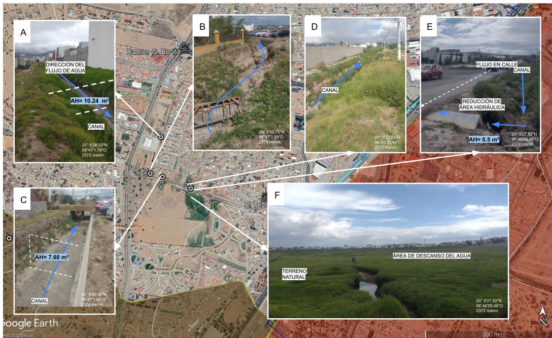
Figura 176. Imagen Satelital Google Earth con Red Hidrográfica Natural, Fotografía A: muestra la sección de un nuevo canal que conduce el agua hacia la fotografía B y C, donde también se observa que el area hidráulica reduce al menos 3 metros cuadrados.
