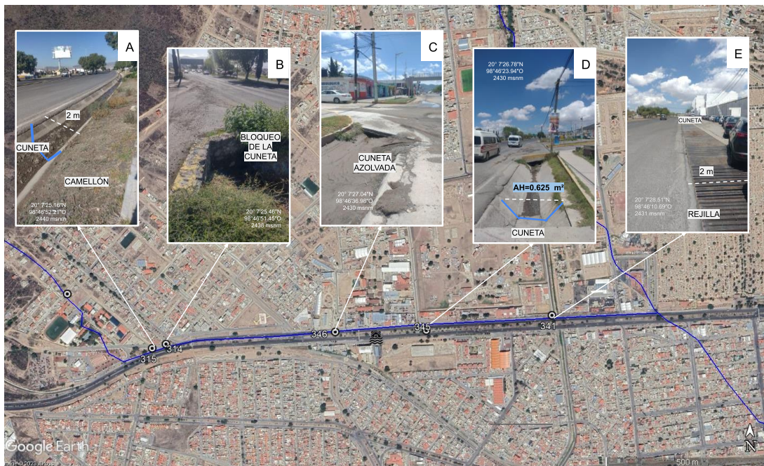
Figura 157. Imagen Satelital Google Earth con Red Hidrográfica Natural, Fotografía A: muestra que el cauce se ha transformado en una cuneta a la orilla de la carretera Actopan-Pachuca de 2 m de ancho, Fotografía B y C: cuneta azolvada que impide el flujo del agua,
