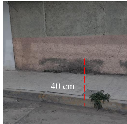
Figura 110. Fotografía con la altura de la marca de agua acumulada, Calle Roble, Colonia el Tezontle.
