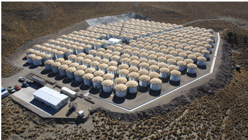
Figura 3.1: Observatorio HAWC. HAWC comprende un conjunto de 300 tanques que registran las partículas creadas de las cascadas de rayos gamma y rayos cósmicos. [11]
