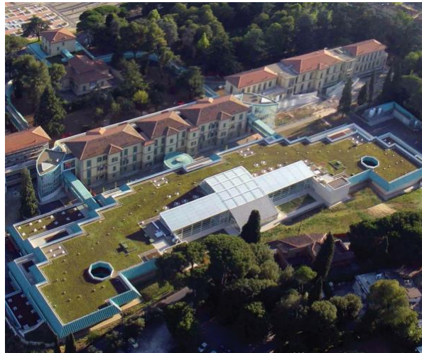
Imagen 22. Hospital Infantil Meyer de Florencia, Italia Fuente: OMS/Salud sin daño
