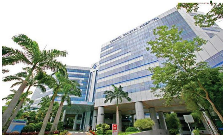
Imagen 21. Hospital General de Changi, Simei, Singapur Fuente: OMS/Salud sin daño
