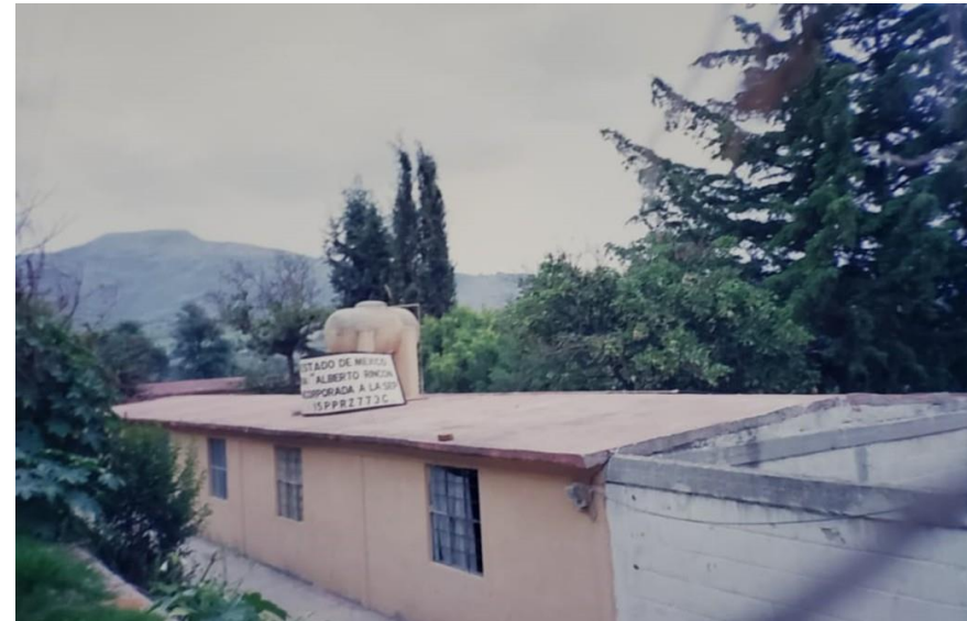
Memoria fotográfica. Estado de la construcción existente en el terreno al inicio del proyecto
