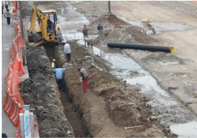
Excavación para sustitución de drenaje pluvial con nueva tubería PAD corrugada de 45 centímetros de diámetro.
