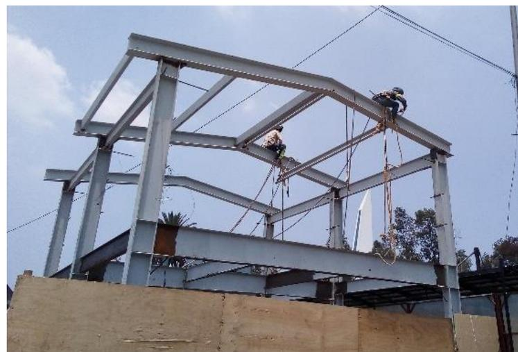
Estructura a base de secciones de acero A-36.
