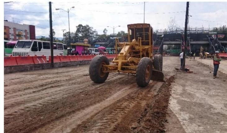
Conformación del terreno con material llamado base controlada.
