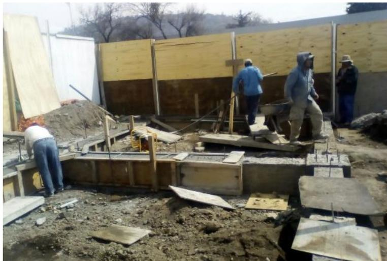
Cimentación a base de zapatas y traves de liga de concreto hidráulico con una resistencia de  $200 \text{ kg/cm}^2$ .
