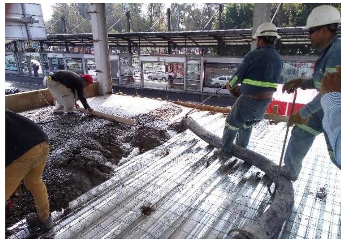
Entrepiso es a base de losacero calibre 22 y losa de concreto premezclado resistencia  $200 \text{ kg/cm}^2$  de 10 centímetros de espesor.
