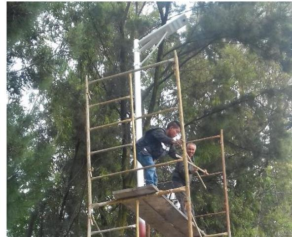
Instalación de luminarias con un poste de 9 metros de altura de luz led con celdas fotovoltaicas.
