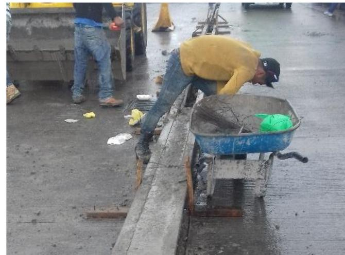
Colado de guarnición de concreto hidráulico con una resistencia de  $200 \text{ kg/cm}^2$  de sección trapezoidal,  $15 \times 20 \times 40 \text{ cm}$ .
