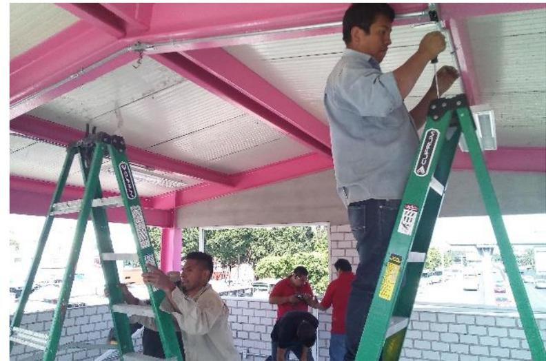
Instalación eléctrica con tubería Conduit, contactos y apagadores aparentes.
