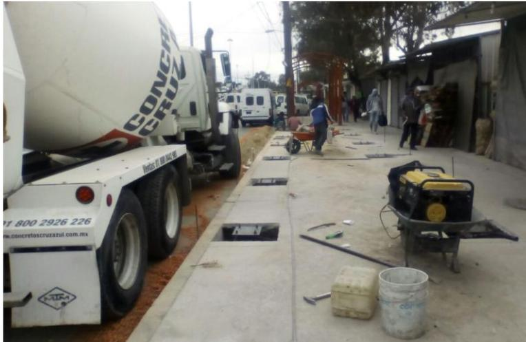
Cimentación de zapatas aisladas para paradas de camión de 70 x 70 centímetros, con concreto premezclado con resistencia de 250 kg/ cm<sup>2</sup>.
