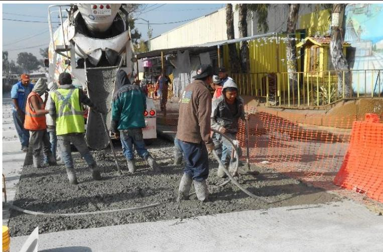
Colado de pavimento de concreto hidráulico premezclado MR 45 kg/cm<sup>2</sup> de 21 centímetros de espesor.
