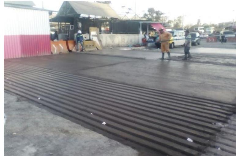
Colado de reductor de velocidad de concreto hidráulico premezclado MR 45 kg/ cm<sup>2</sup>
