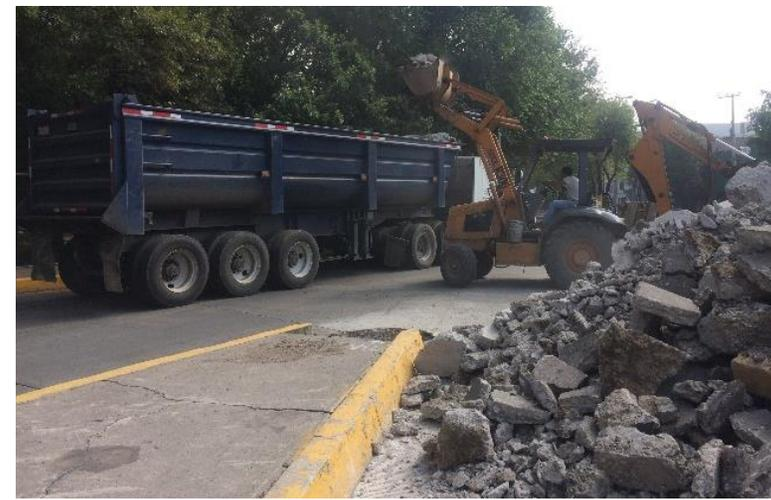
Carga y acarreo producto de demolición de banqueta.
