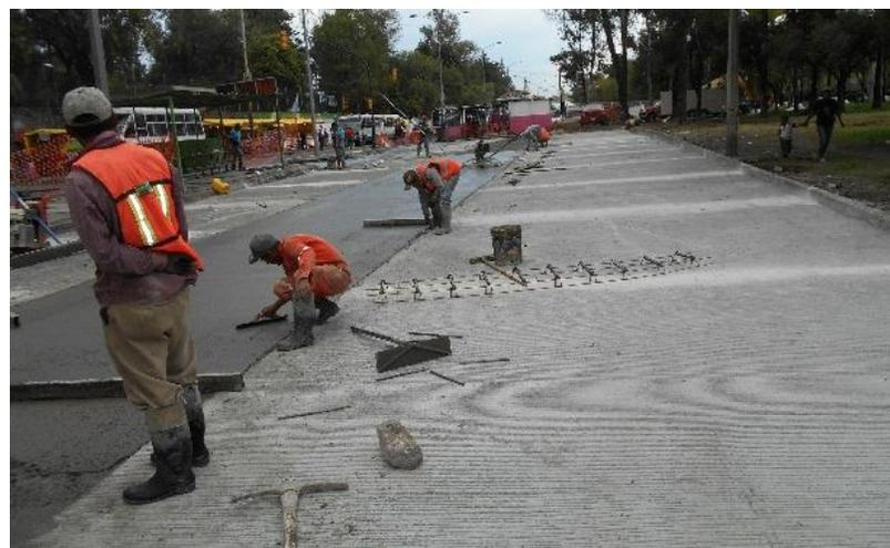
Corte en losas de pavimento hidráulico conforme a proyecto y acabado.
