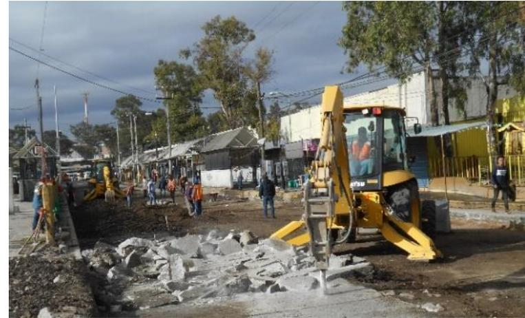
Demolición de pavimento de concreto hidráulico existente con retroexcavadora.
