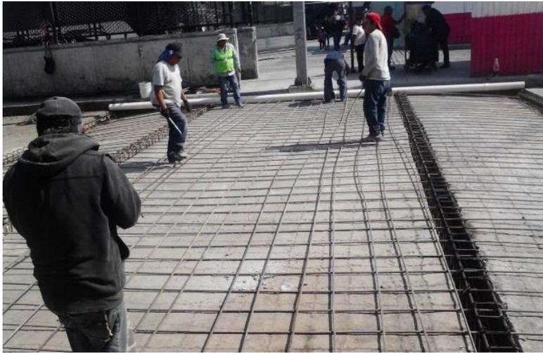
Armado del reductor de velocidad con varillas del número 4.
