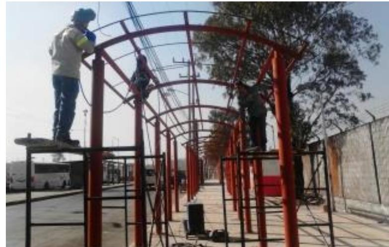
Estructura metálica para parada de camión con tubos de 6 pulgadas de diámetro para columnas y tubos de 3 pulgadas de diámetro para la techumbre.
