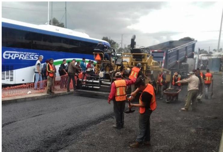
Colocación de base negra con espesor de 10 centímetros.
