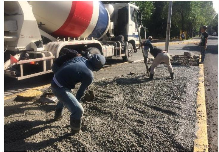
Colado de banqueta de 10 cm de espesor con concreto hidráulico  $f_c=150 \text{ kg/cm}^2$
