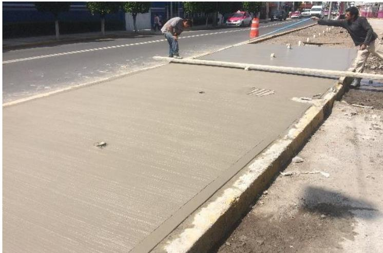
Acabado en banqueta tipo escobillado y volteador.
