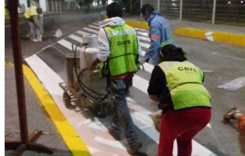
Aplicación de balizamiento en andenes vehiculares con pintura termoplástica color blanco y microesferas reflejantes.
