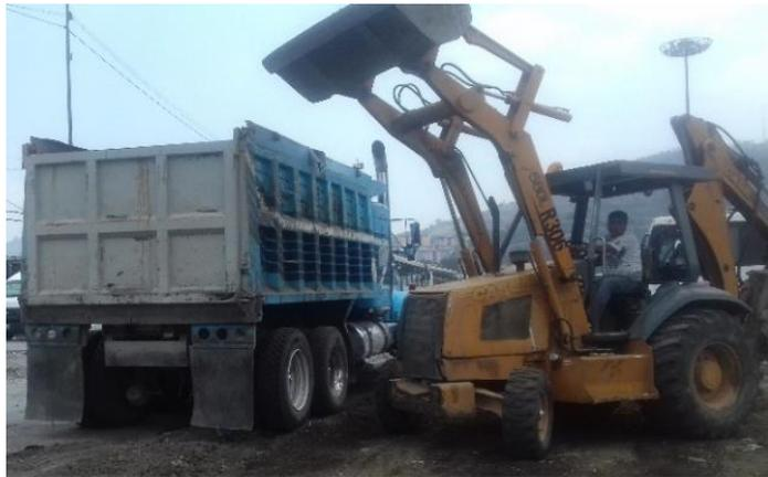
Carga y acarreo de material producto de demolición, en camión tipo Torton.
