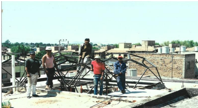
Montaje de estructura
