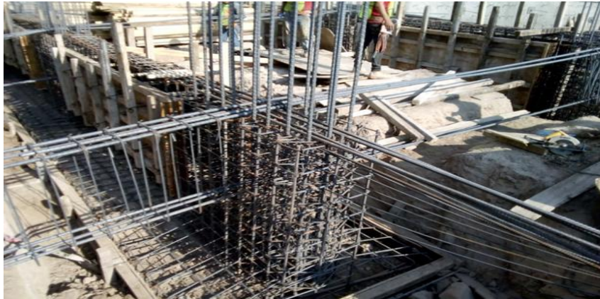
DETALLE DEL PERALTE DE LAS CONTRATRABES DE CIMENTACION
