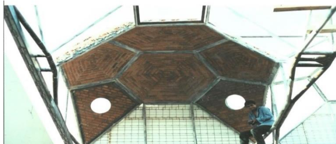
Primer módulo cerrado con bóveda de ladrillo recargado y prueba de carga
