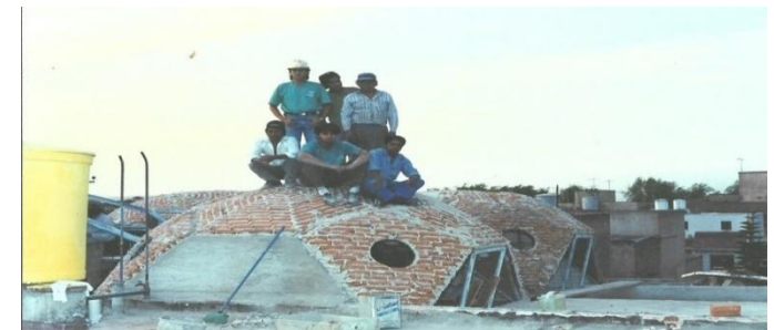
Primer módulo cerrado con bóveda de ladrillo recargado y prueba de carga
