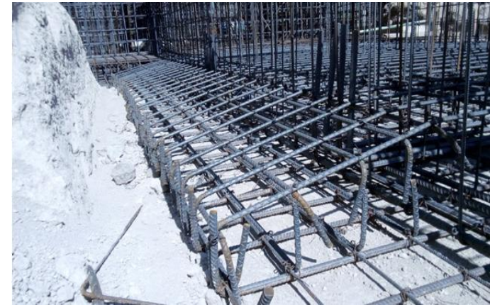
DETALLE DEL PERALTE DE LAS CONTRATRABES DE CIMENTACION
