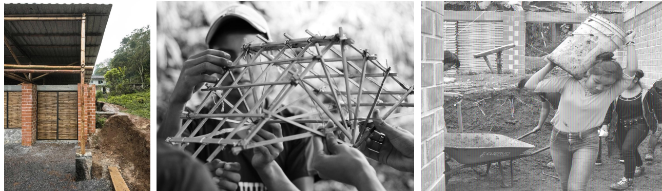
Imagen 36. (2018). Fotografías de la comunidad trabajando en la construcción del proyecto. FUENTE. ArchDaily México.
