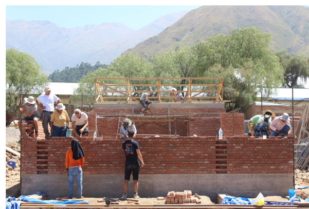
Imagen 42-43. (2017). Fotografía de la comunidad trabajando en la construcción del proyecto. FUENTE. ArchDaily México.
