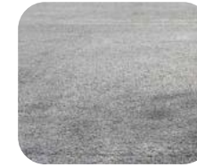
ACABADO DE CONCRETO PERMEABLE
